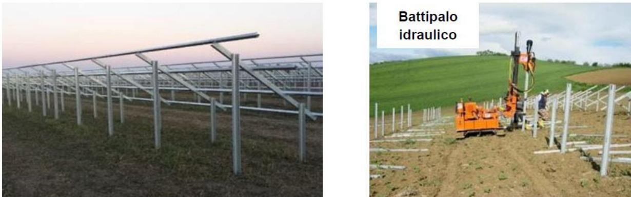
Figura 5-1 – Esempio di posa delle strutture portanti.
