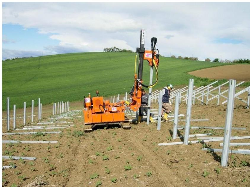
**Figura 4-5 – Posa strutture metalliche di fondazione**
