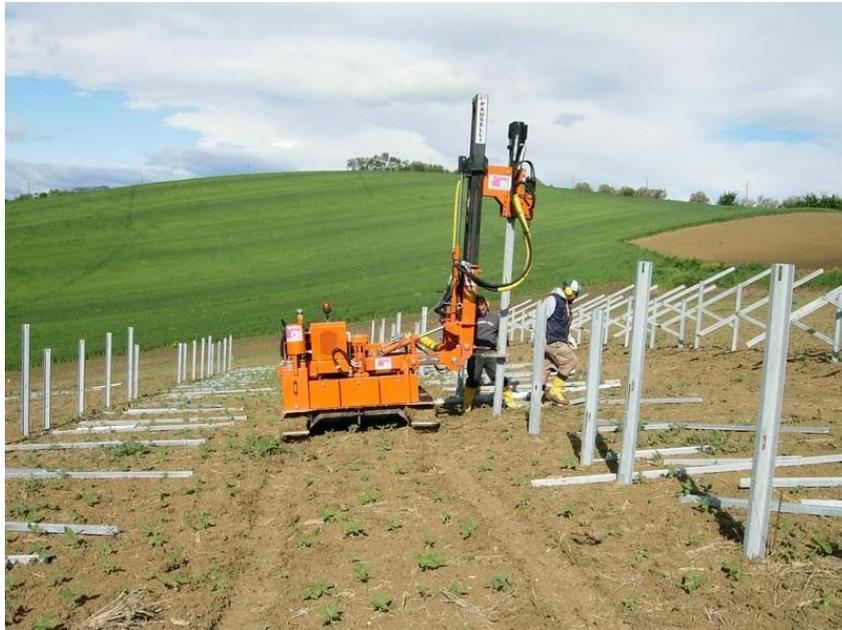
**Figura 2-1 – Posa strutture metalliche di fondazione**
