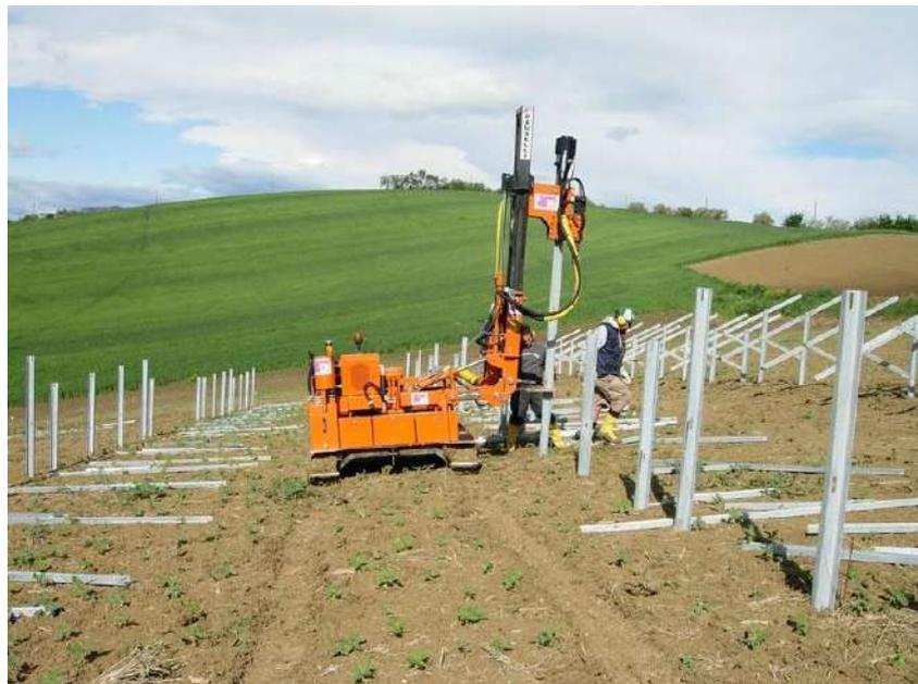
**Figura 3-2 – Posa strutture metalliche di fondazione**
