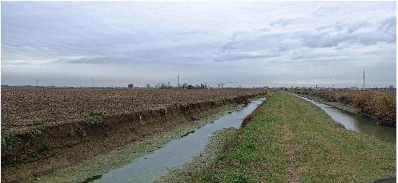
Foto 6 - Vista Nord Area Impianto Ovest Scoli Roveri (sx) e Busi Destro (dx)
