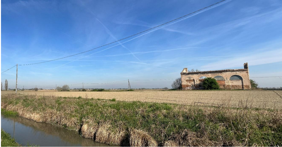
Foto 3 - Vista Sud dell'area Impianto Est
