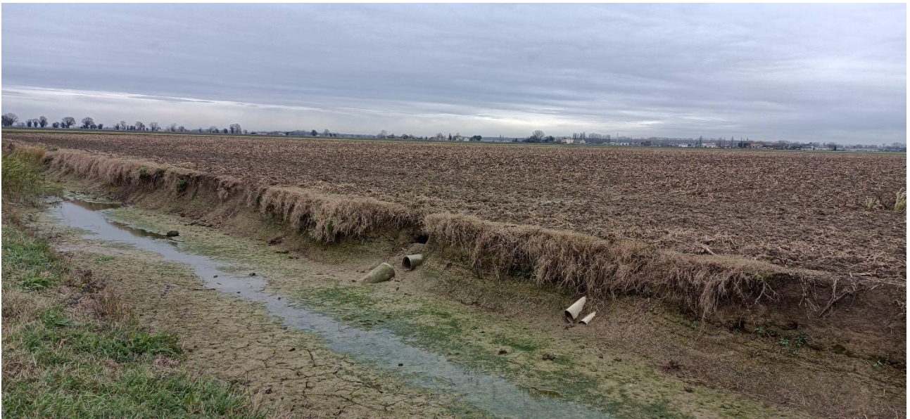
Foto 7 - Vista Nord Area Impianto Ovest – Scarichi scoline su scolo Roveri
