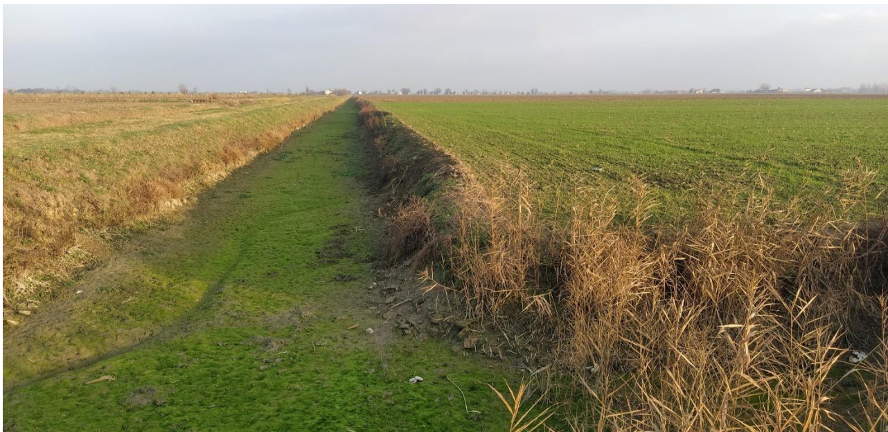
Ripresa 6 Campo Ovest, dal vertice nord-ovest, canale di bonifica.
