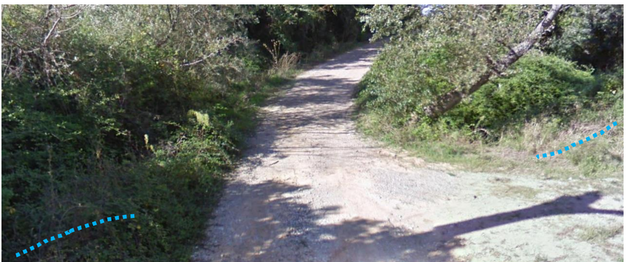
Figura 2-4: il passaggio in corrispondenza del piccolo ponticello. In ciano, l'indicazione dell'asse del Mannara, oltre 1,5 m al di sotto del piano stradale.
