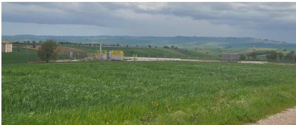
Figura 4-7: area pozzo adiacente all'area Rotello 2.
