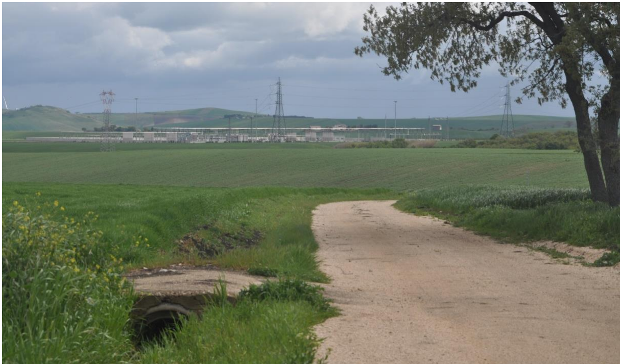
Figura 4-5: stazione elettrica esistente.
