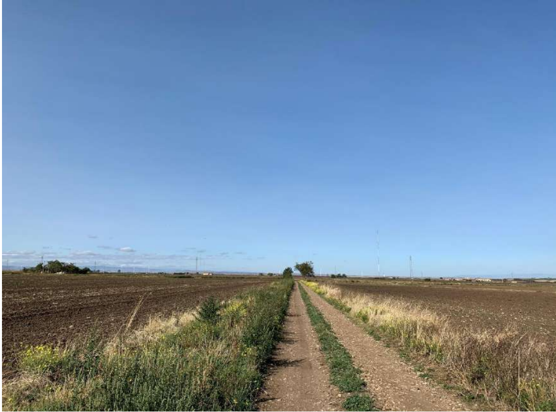
Foto 4. Cavidotto. Strada sterrata. Vista da N
