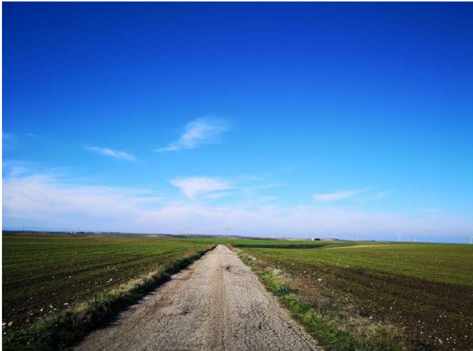
Foto 8. Cavidotto. S.P. 127 di Ariaccia. Vista da SE.
