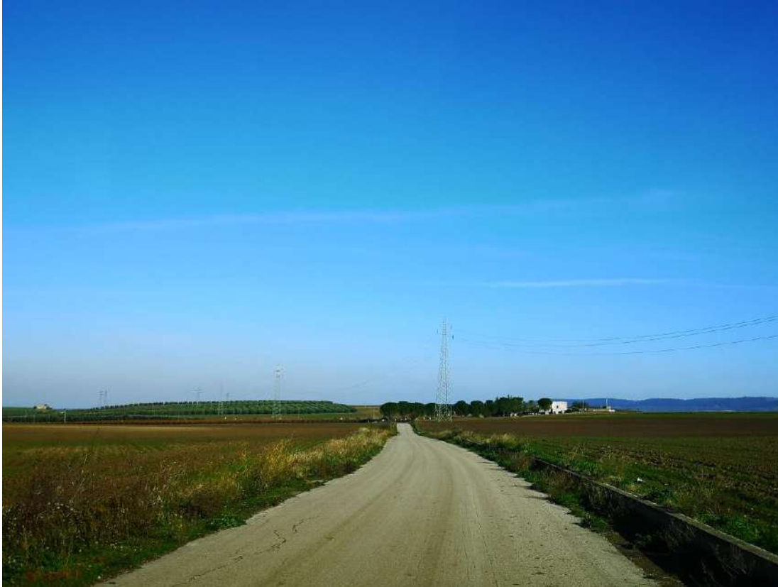
Foto 12. Cavidotto. S.P. 44. Vista da S
