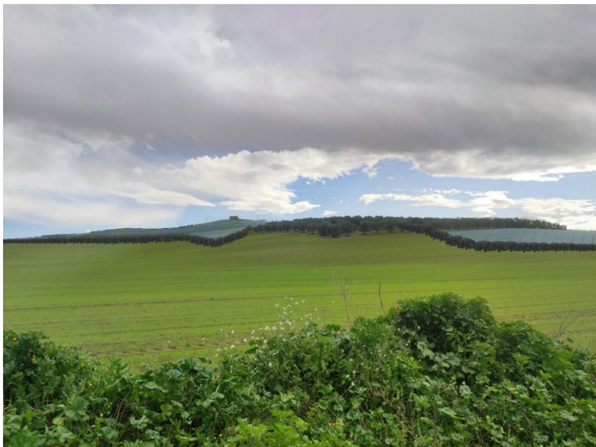
Figura 14 - Punto di Presa 5a - Regio Tratturello Canosa Monteserico Palmira - Stato di Progetto
