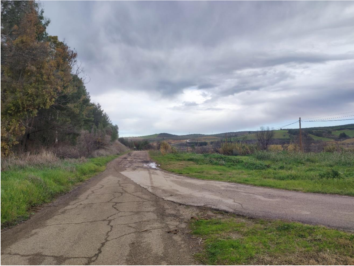
Figura 9 - Punto di Presa 4b - Stato di Fatto - Masseria Brandi
