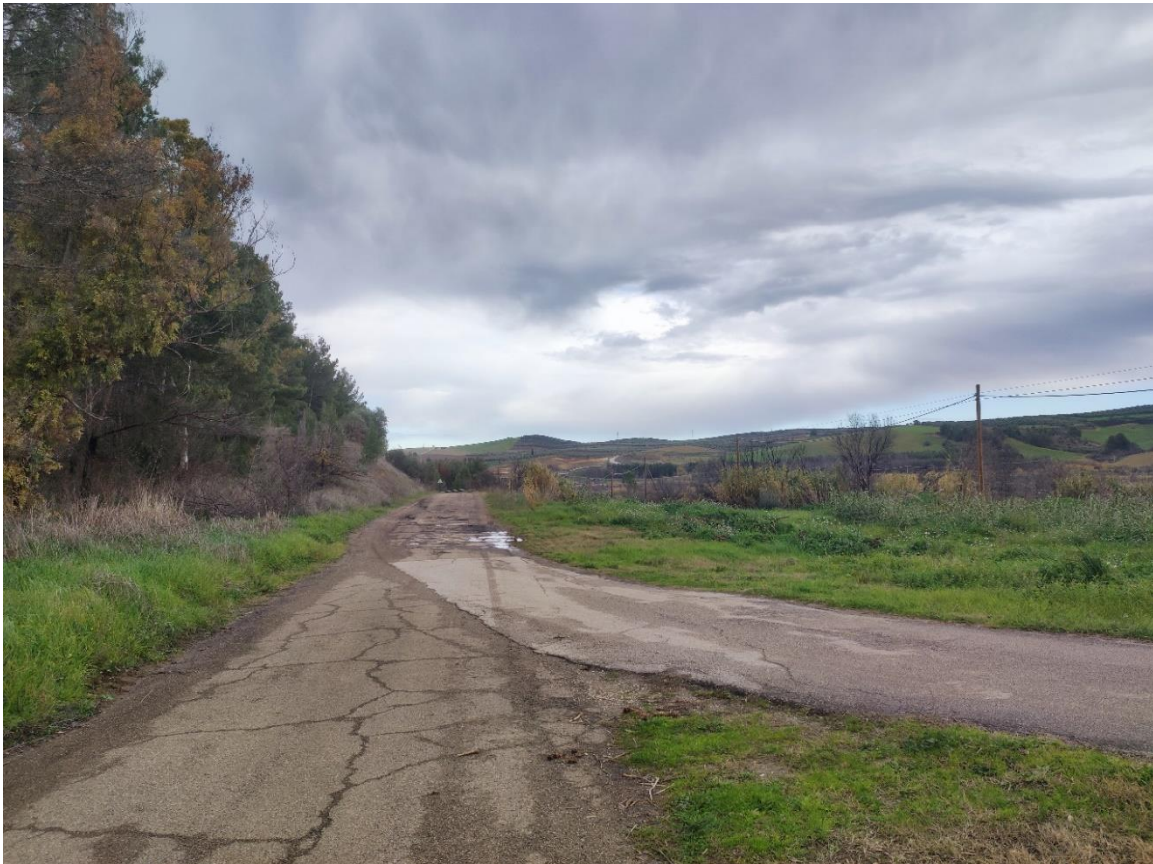
Figura 88 - Punto di Presa 4b - Stato di Fatto - Masseria Brandi
