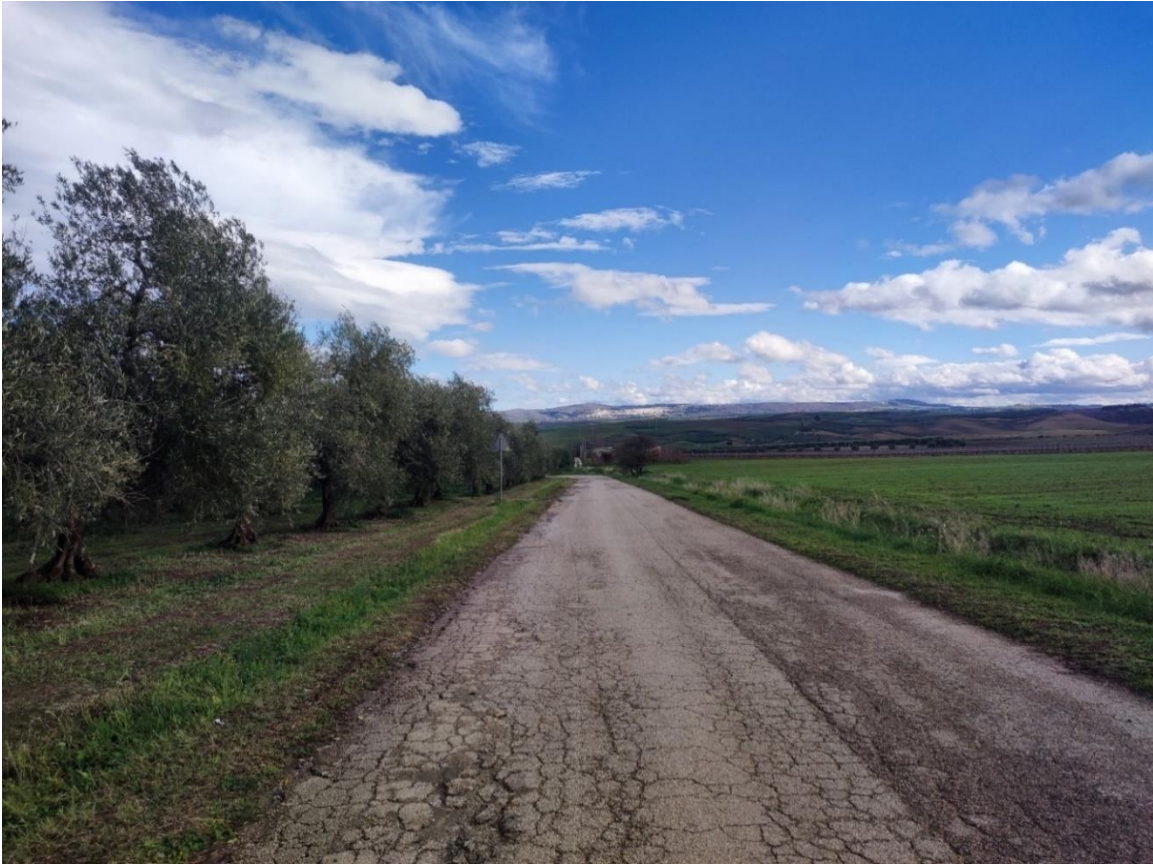
Figura 100 - Punto di Presa 6 - Regio Tratturello Lavello - Minervino - Stato di Fatto
