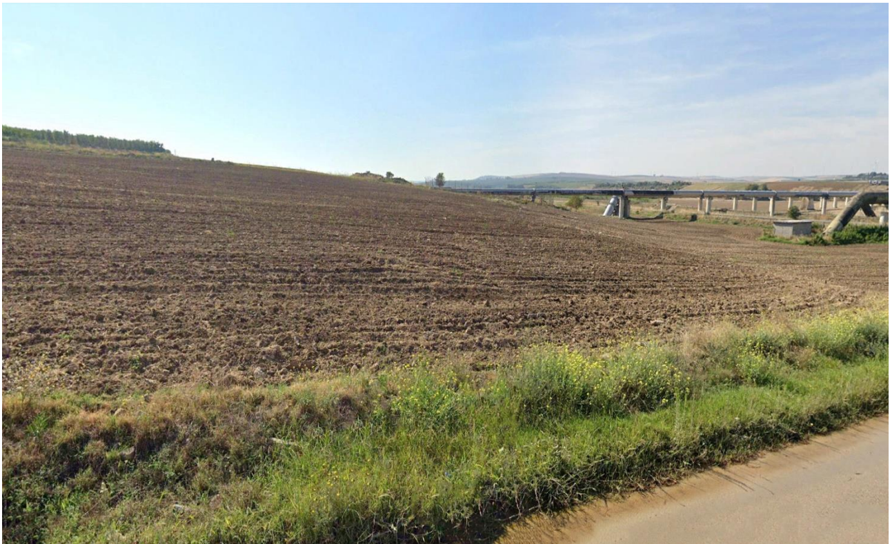
Figura 57 - Punto di Presa 10 - Regio Tratturello Lavello - Minervino - Stato di Fatto
