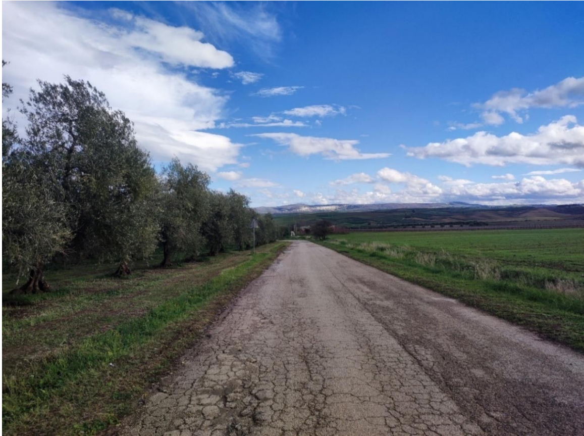
Figura 37 - Punto di Presa 6 - Regio Tratturello Lavello - Minervino - Stato di Fatto
