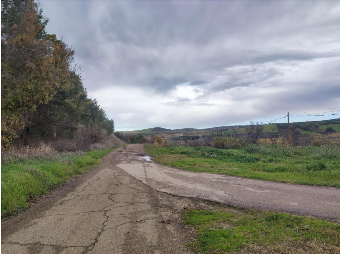
Figura 25 - Punto di Presa 4b - Stato di Fatto - Masseria Brandi
