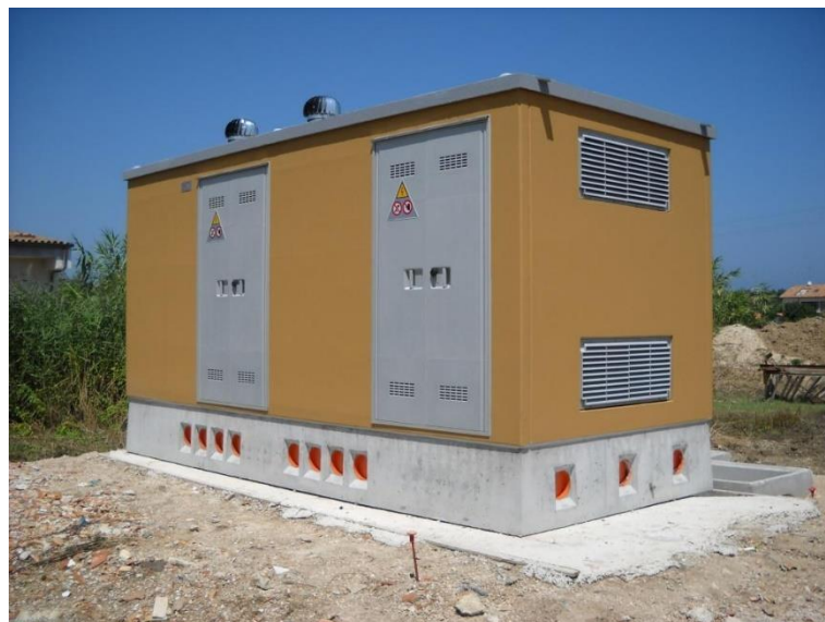
Figura 2.10: Immagine rappresentativa della Cabina di Sezionamento
