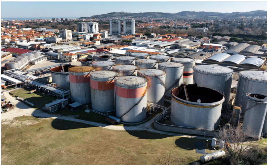
Figura 2-1 – Vista dell'impianto attuale a Pesaro (vista verso ovest da via Senigallia)
