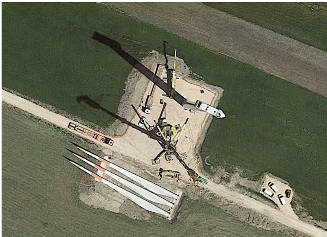
Figura 3.6: Esempio di piazzola in fase di costruzione
