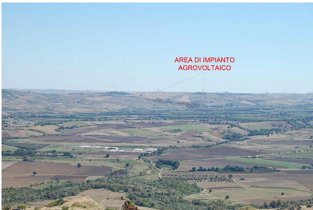
Figura 6: Vista prospettica dell'area di impianto con fotoinserimento da Guglionesi "1_OSS_STA" distante 10 km dall'area di impianto agrovoltaico in progetto.
