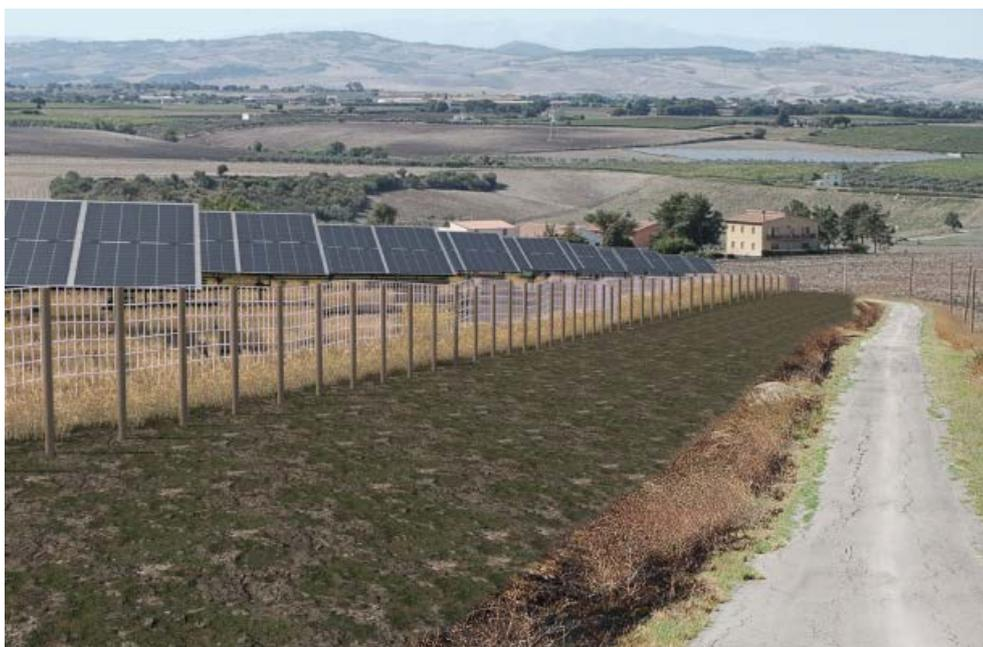
*Figura 11: Tipologia di recinzione metallica con montanti in castagno*
