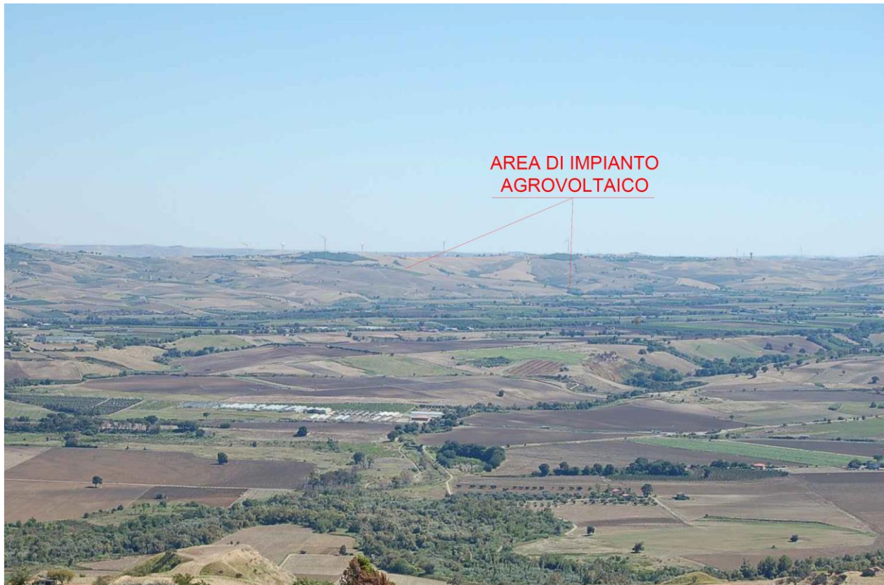
Figura 82: Vista prospettica dell'area di impianto da Guglionesi "1_OSS_STA" distante 10 km dall'area di impianto agrovoltaico in progetto
