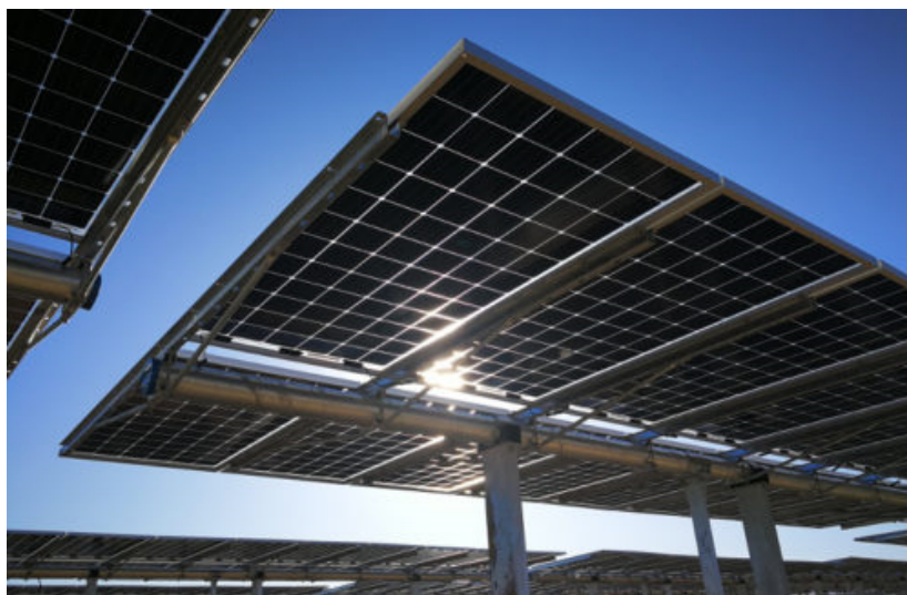
Figura 3.4 Esempio di struttura a tracker monoassiale.
