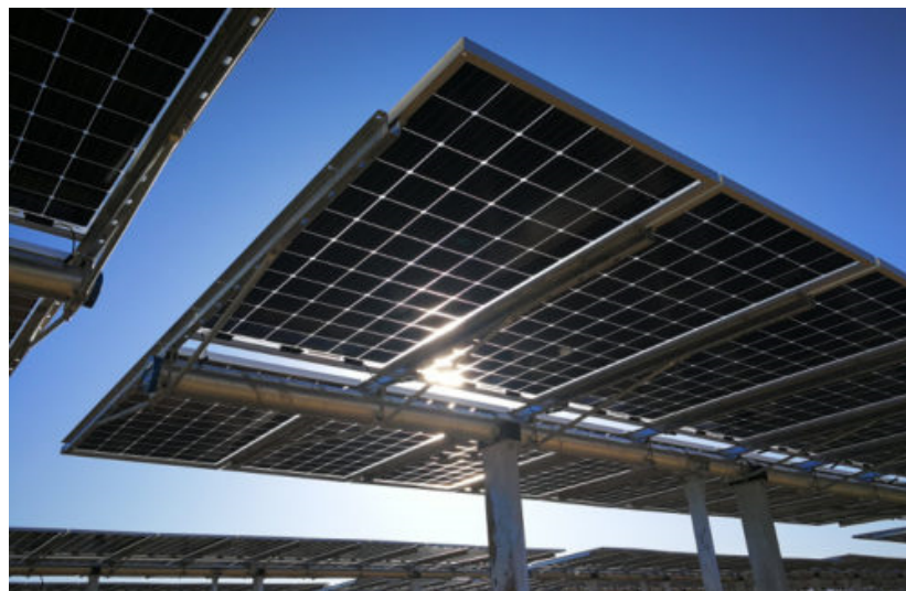
Figura 4.3 Esempio di struttura a tracker monoassiale.
