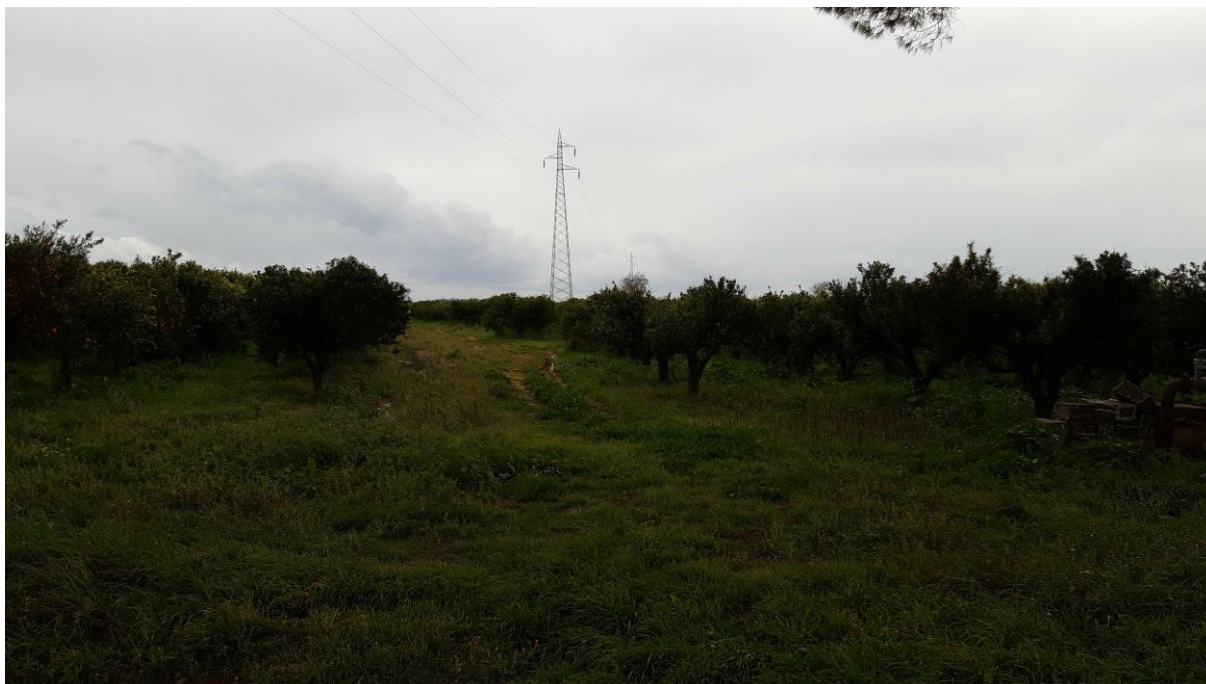
Figura 2.3: Elettrodotto di Alta Tensione
