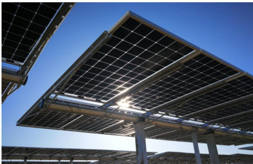
*Figura 2.2 Esempio di struttura a tracker monoassiale.*
