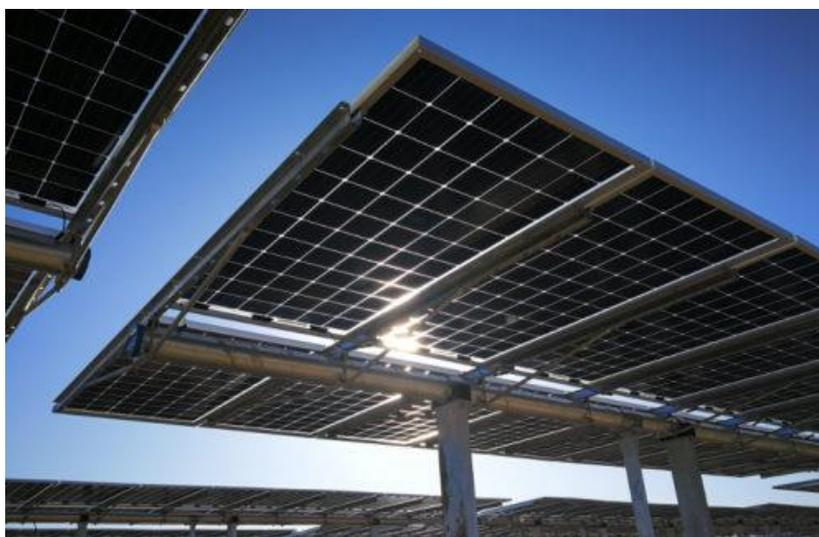
*Figura 2.8 Esempio di struttura a tracker monoassiale.*
