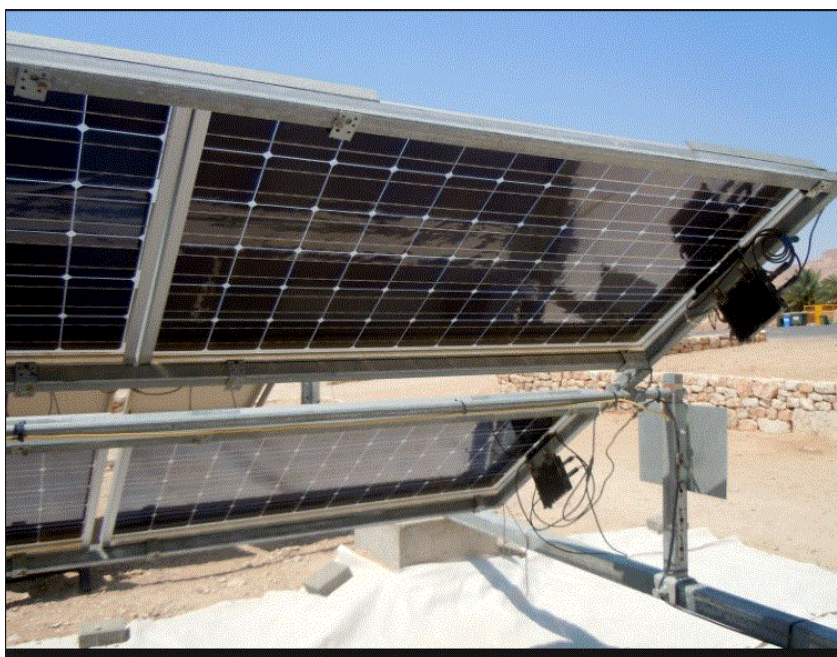
Fig. 5.1-1 Tipico Modulo fotovoltaico Bifacciale
