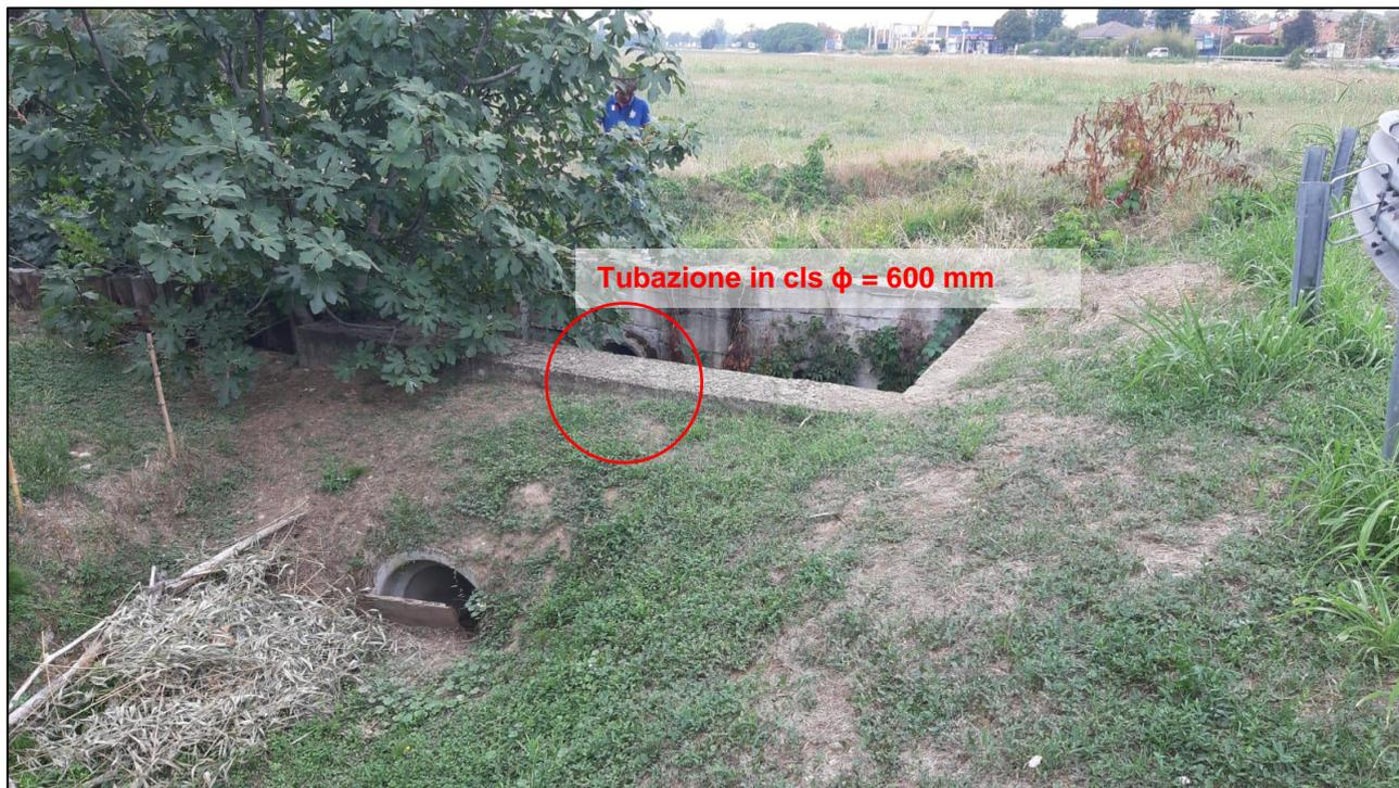
Figura 16 – Nodo Idraulico 2, tubazione esistente che fungerà da scolmatore per le portate di piena
