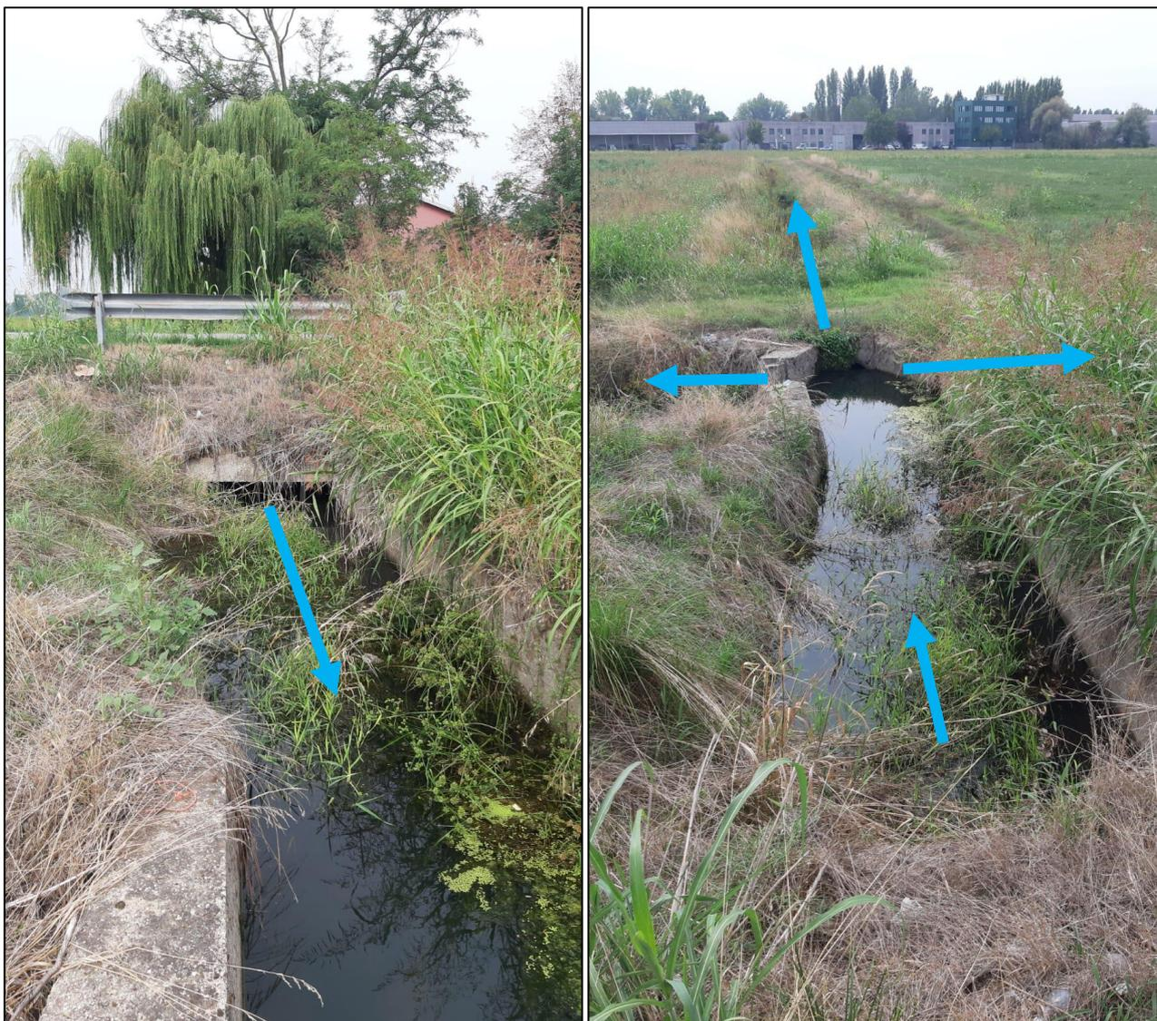
*Figura 8 – Nodo idraulico 1, attraversamento del Cavo Ciano sotto SP30 vista verso monte e vista verso valle*
