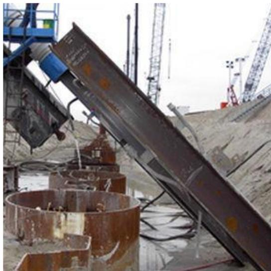
Figura 5.2: Esempio di palo battuto con gargame di collegamento
