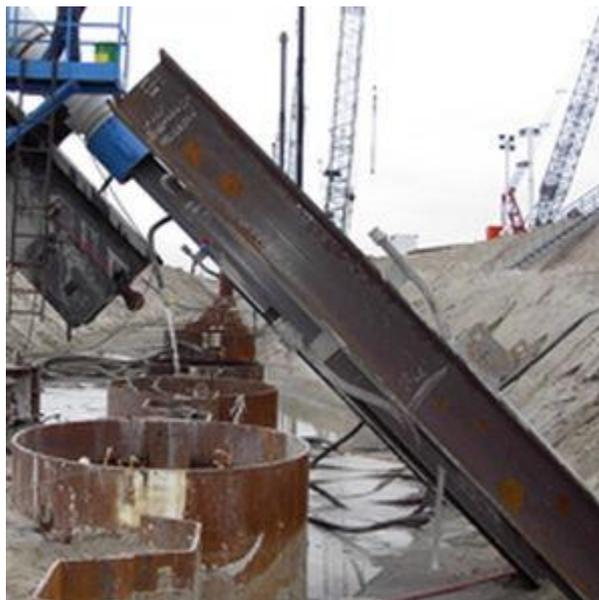
Figura 43: esempio di palo battuto con gargame di collegamento
