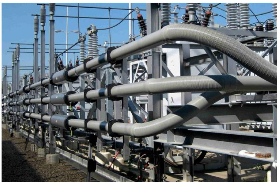
Figura 5.4: Esempio di installazione Sistema IPB (Isolated Phase Bus) – fonte: Duresca ® Bus bar system (Moser Glaser)
