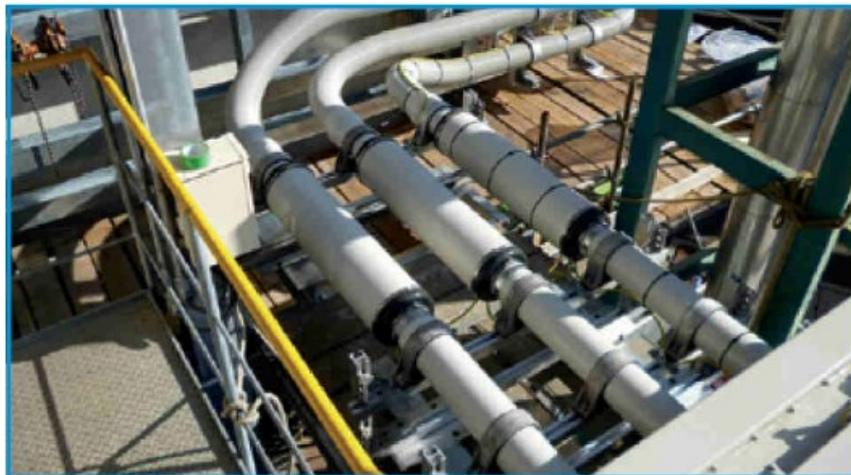
Figura 5.3: Esempio di installazione Sistema IPB (Isolated Phase Bus) – fonte: Duresca ® Bus bar system (Moser Glaser)
