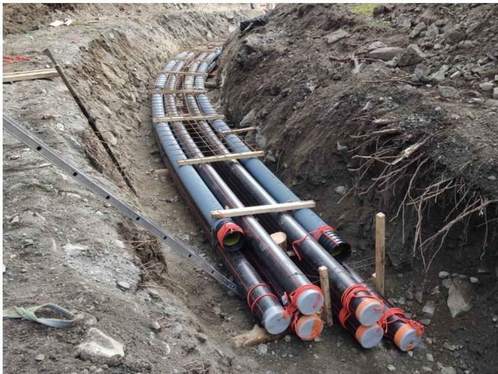
**Figura 5.2: Esempio di posa in trincea**
