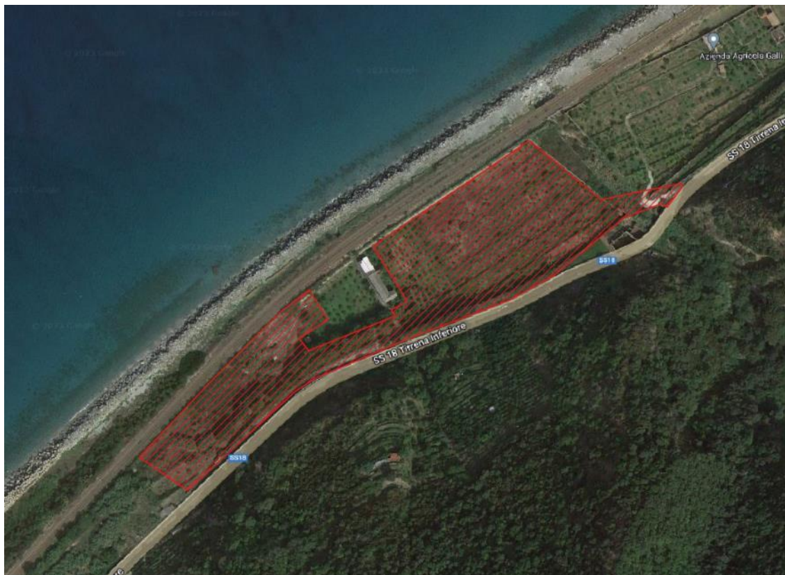
Figura 3.16: Area Cantiere Galleria Accesso – G
