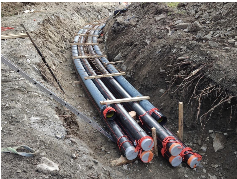
Figura 3.17: Esempio di posa in trincea
