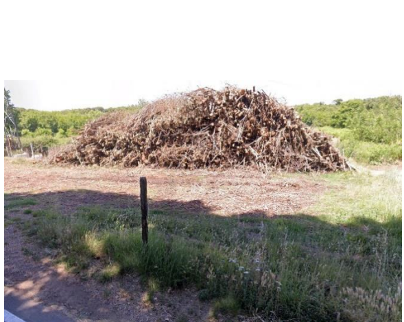
Area cantiere deposito individuata come idonea al deposito di mezzi e materiali
