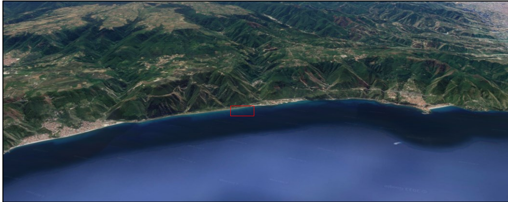
Figura 2.1: Costa compresa tra Bagnara Calabra e Scilla (in rosso l’area d’intervento)
