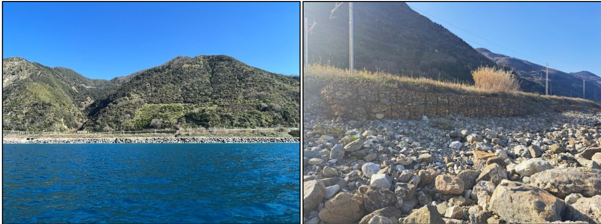
Figura 8.2: Area oggetto d’intervento in prossimità dello sfocio del torrente Mancusi.
