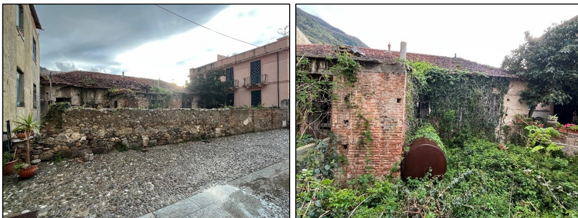
Figura 7.4: Favazzina. Strutture produttive del XIX secolo.
