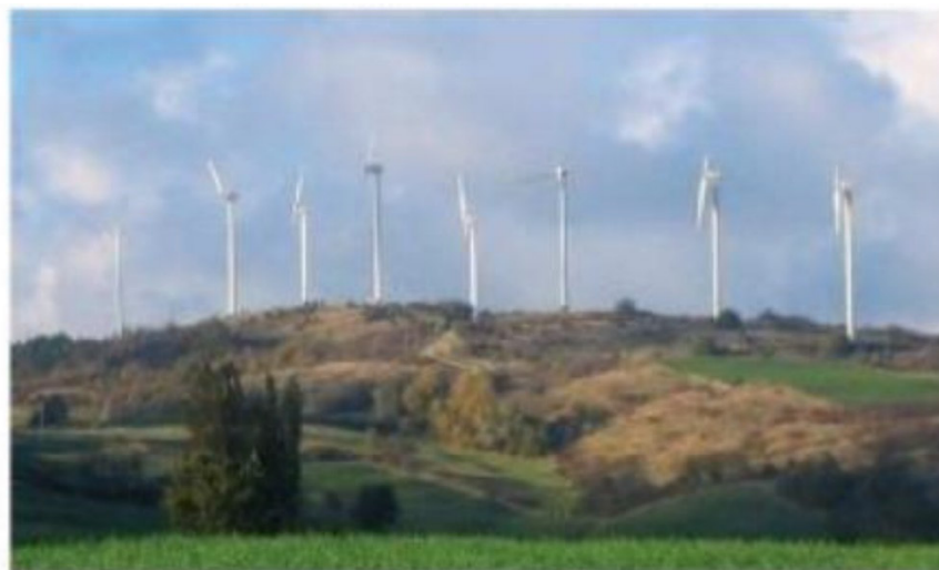
Esempio di parco eolico
