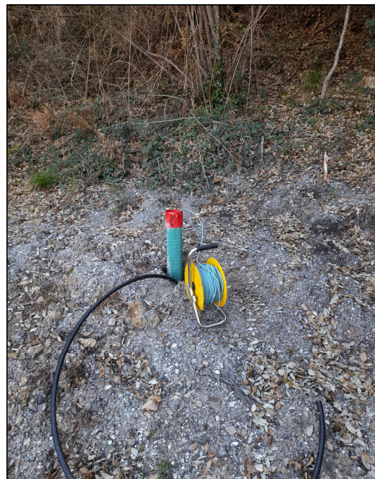
Monitoraggio acque sotterranee
