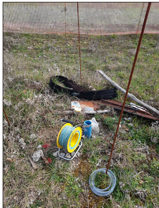
Monitoraggio acque sotterranee
