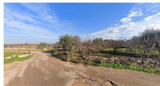
R2 - muretto a secco interferente in cattivo stato, da smontare e ricomporre successivamente
