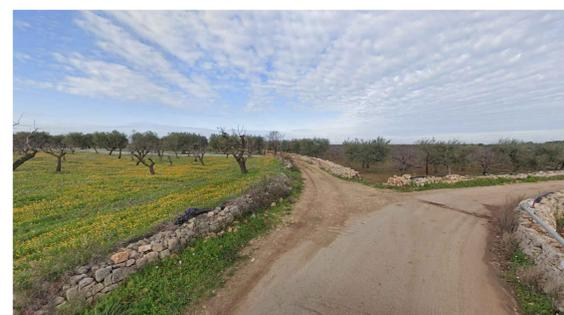
R9 - muretto a secco interferente in cattivo stato, da smontare e ricomporre successivamente
