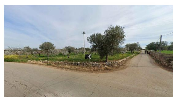
R14 - muretto a secco interferente in cattivo stato, da smontare e ricomporre successivamente
