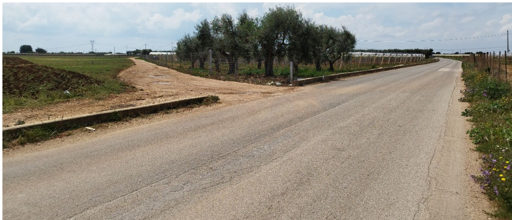
Viabilità in conglomerato bituminoso esistente
