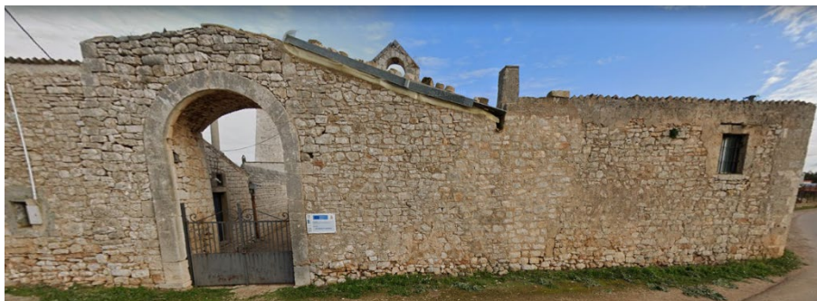
Masseria fortificata "panicelli"
