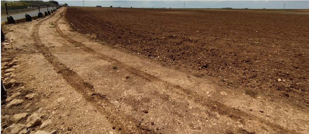
Viabilità esistente con pavimentazione naturale in discreto stato
