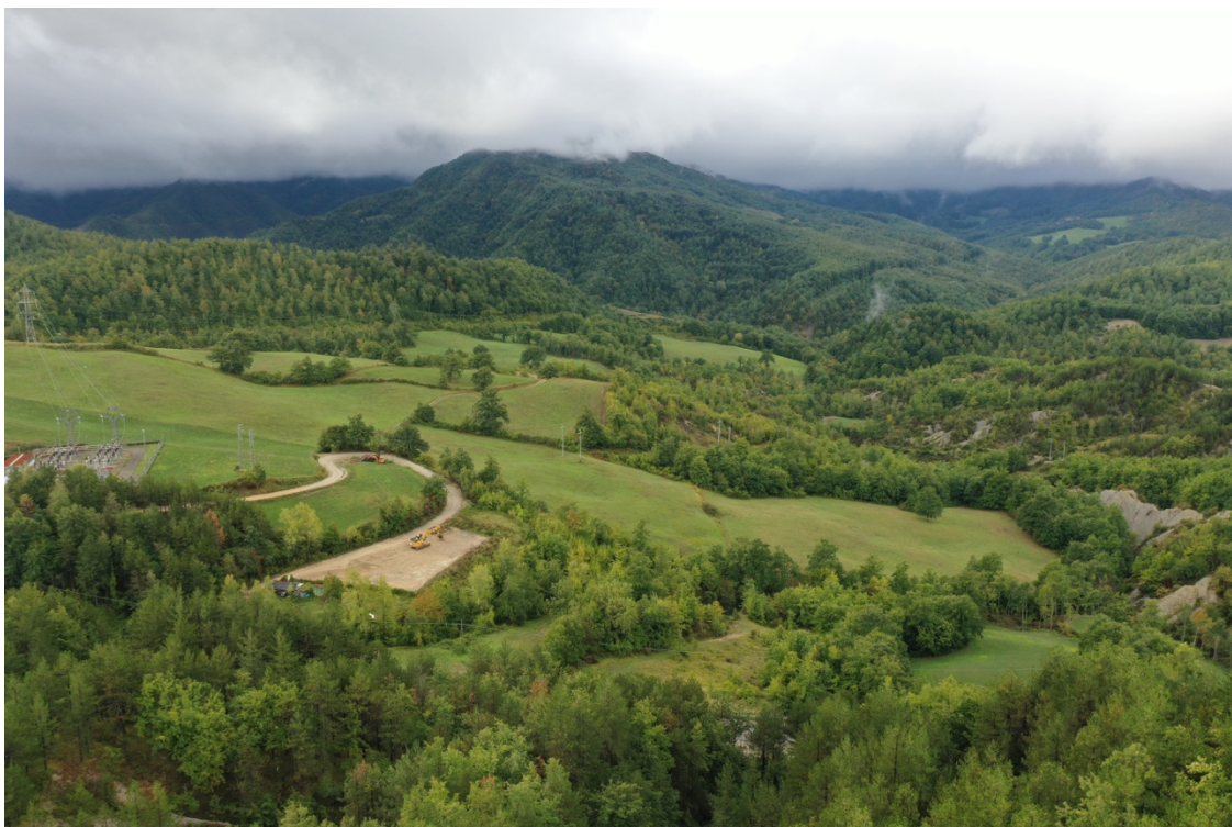
Fig. 29 Foto di un tratto della strada su cui sarà realizzato il cavidotto di connessione, nei pressi dell'aerogeneratore BT03.
