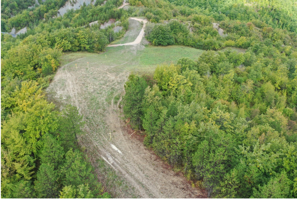
Fig. 31-37. Foto riprese da drone di alcuni tratti del cavidotto di connessione e dell'area in cui sorgerà l'impianto
