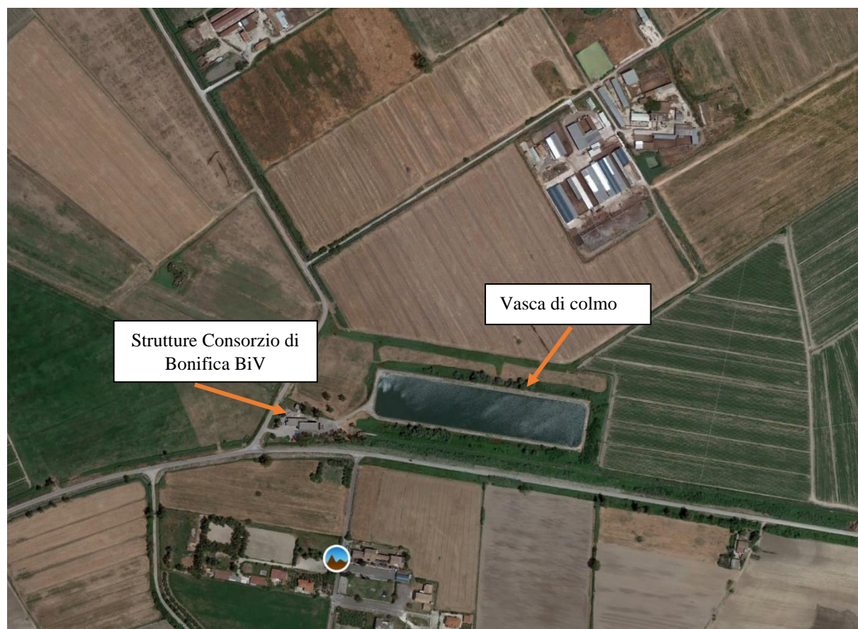
Figura 20: Dettaglio vasca di colmo consortile
