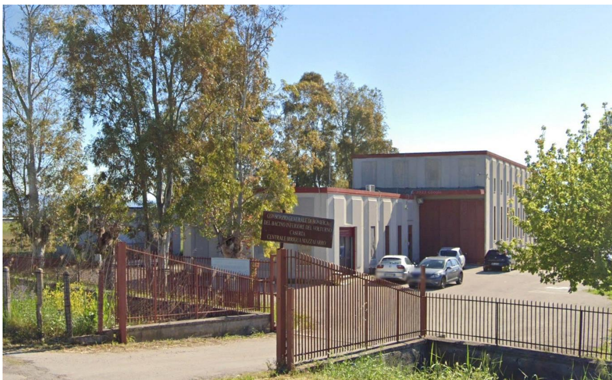
Figura 21: particolare uffici consortili
