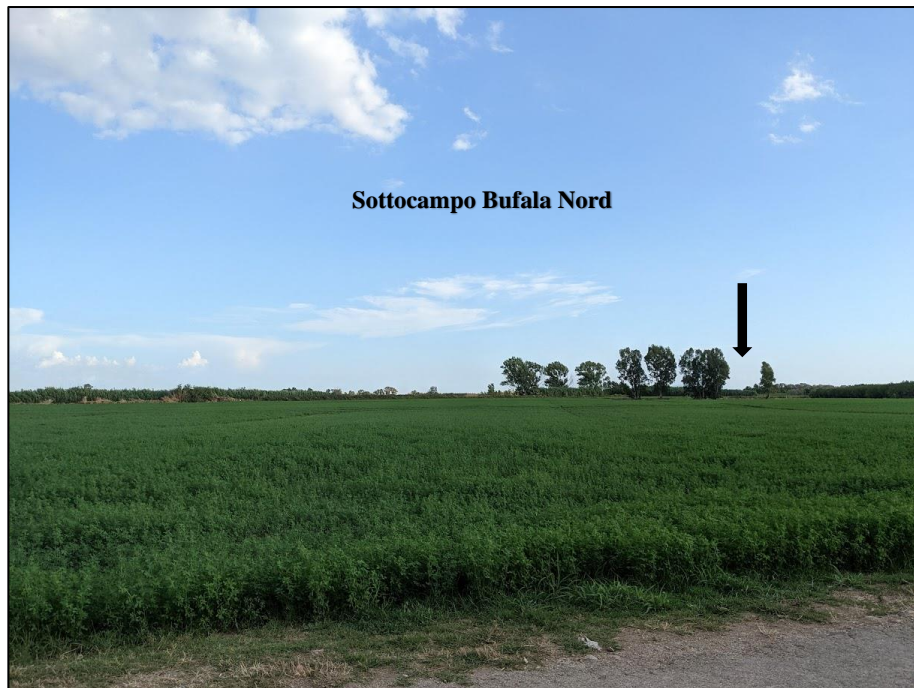
Figura 38: FOTO 2 – vista da nord dell'impianto
