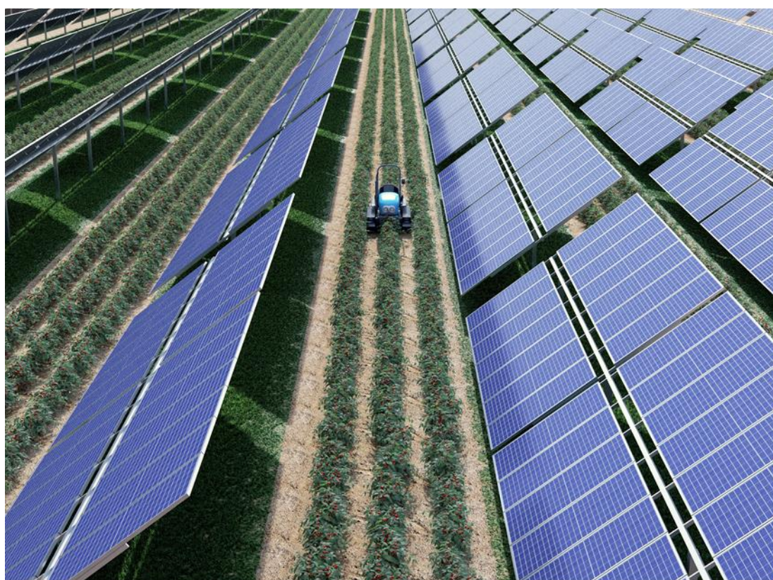
Figura 99: Simulazione di attività agricola interfilare di manutenzione delle aree libere di impianto
