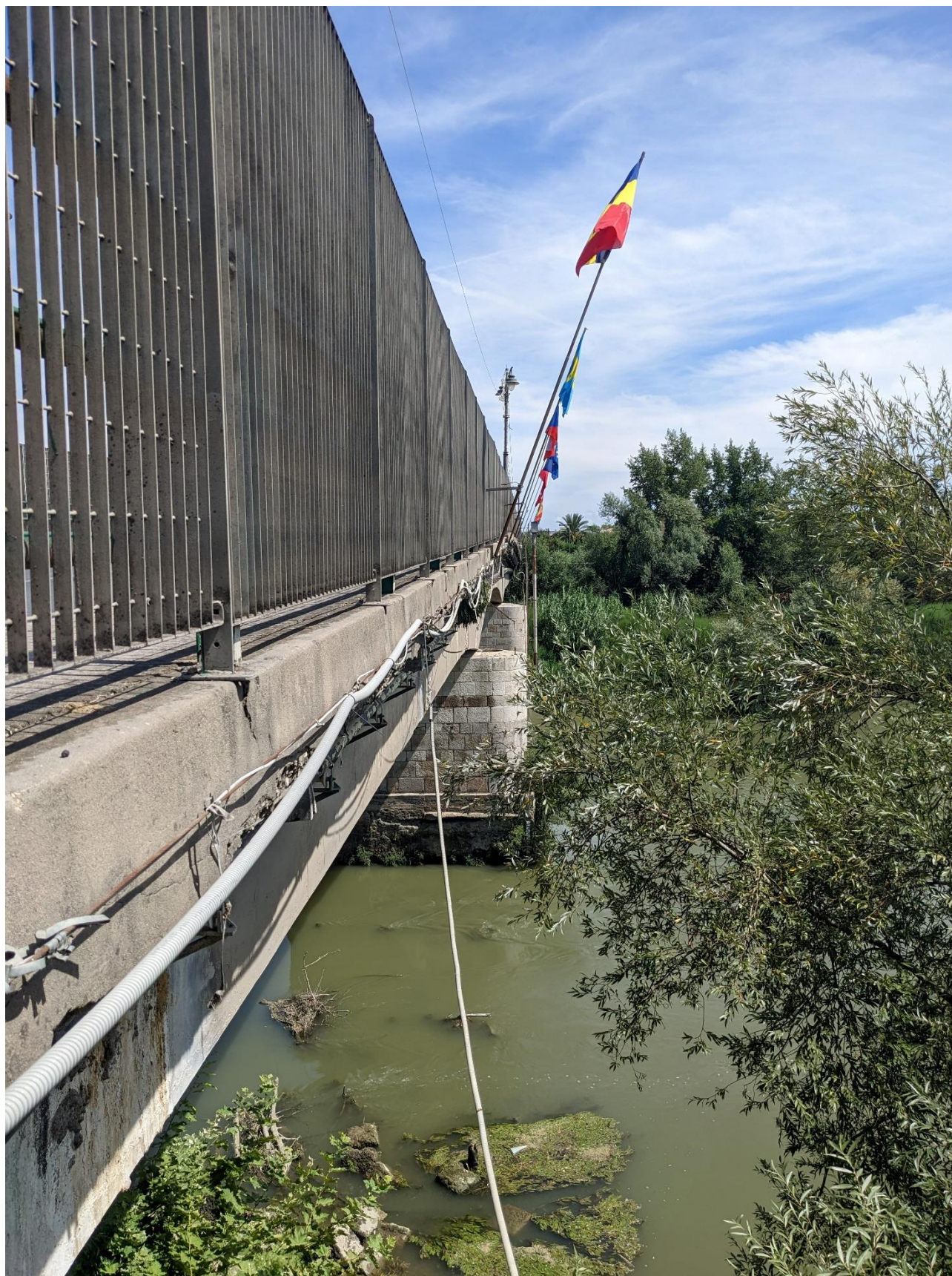
Figura 12: Dettaglio Ponte Fiume Volturno - stato di fatto
