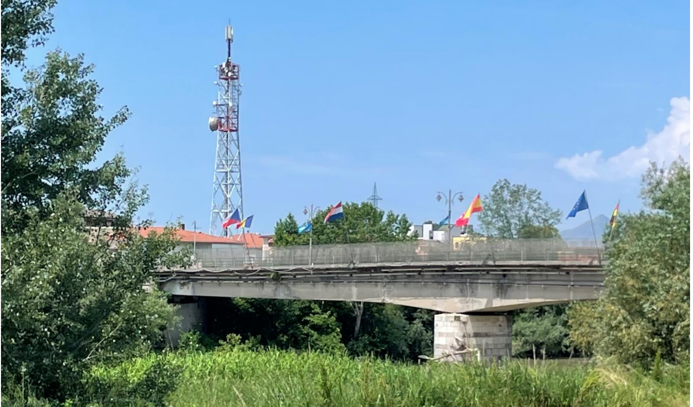
Figura 10: vista Ponte Fiume Volturno Stato di fatto
