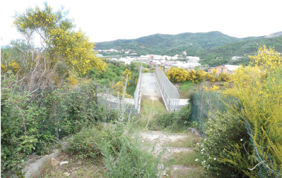
Figura 5-1 – Passaggio pedonale sopra l'autostrada dei fiori attualmente in stato di abbandono e verosimilmente utilizzato da alcune specie animali. Il passaggio sarà oggetto di demolizione.
