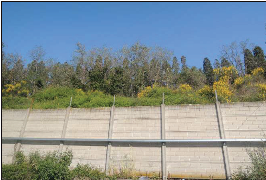
Figura 2-23 – Tratto della boscaglia mista degradata con arbusti termofili.
