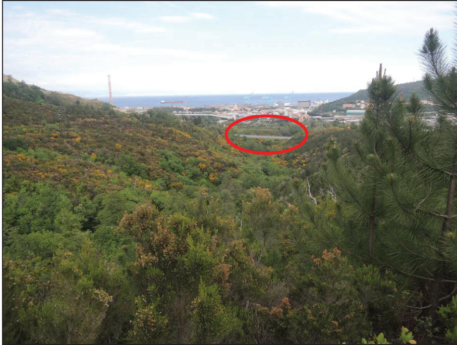
Figura 2-20 – Visione d'insieme della valle del rio Termini: nel cerchio rosso l'attuale tracciato autostradale che attraversa la valle del rio Termini, in prossimità del quale verrà realizzato il nuovo svincolo.
