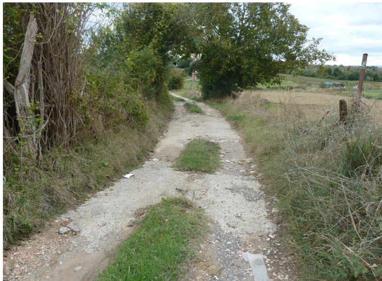
Figura 50 – 1- veduta avvio strada interpoderale da SR 312
