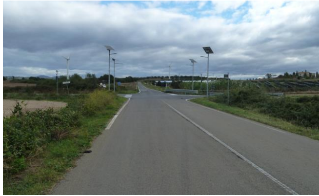
Figura 44 - Veduta dell'incrocio da Ovest
