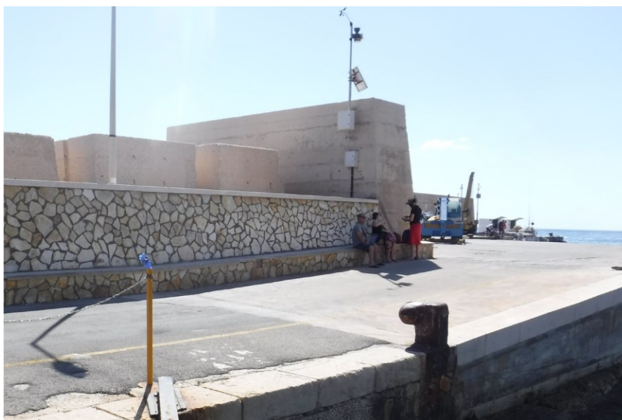
Figura 6 - Inizio tratto muro paraonde a quota + 6,30 s.l.m. (tratto non rivestito fino alla testata)
