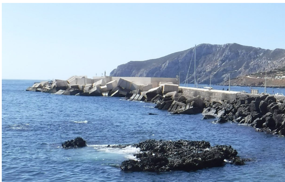
Figura 38 - Foto dello stato attuale nel tratto di mantellata da ricaricare
