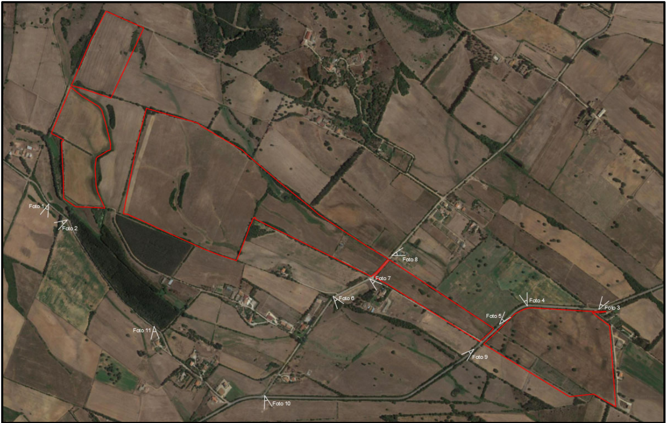
Figura 17 - Inquadramento foto impianto
