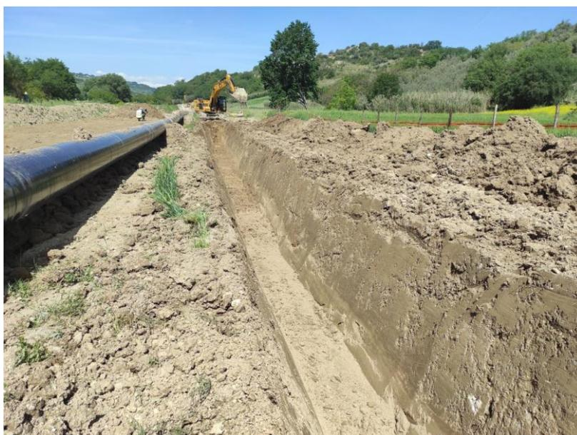
Fig. 2 – Scavo della trincea – separazione tra terreno scavato (a destra) e l'humus precedentemente accantonato (a sinistra)
