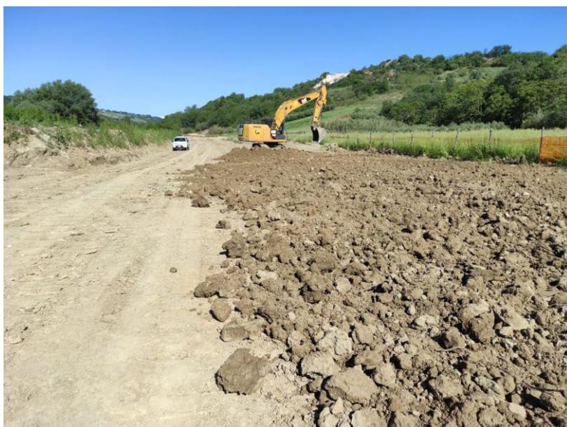
Fig. 3 – Preparazione dello strato di contatto terreno-humus (riprofilatura)
