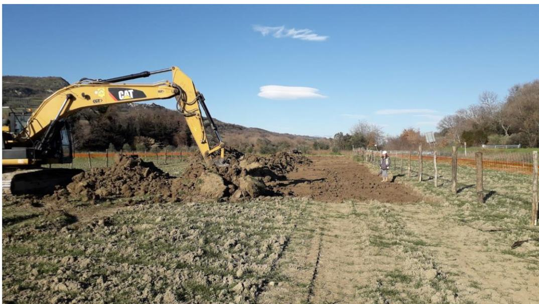
Fig. 1 – Apertura pista di lavoro con accantonamento (a sinistra) dello strato superficiale di terreno (humus)
