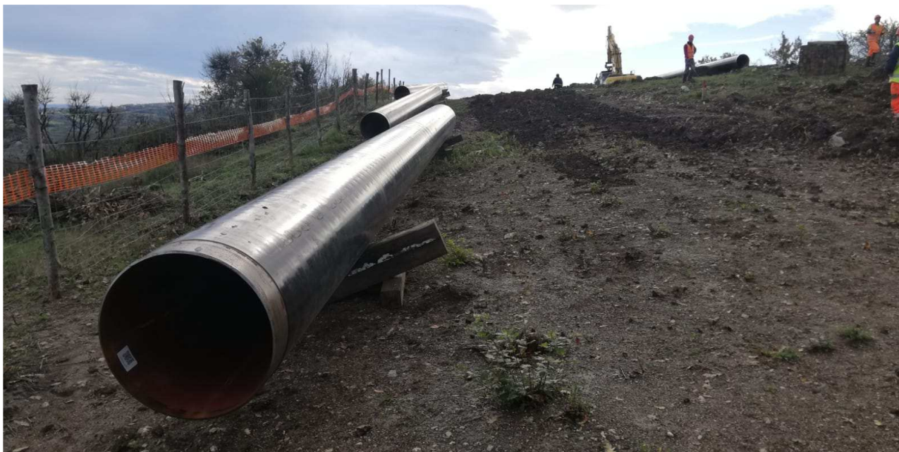
Figura 2.5 – Tubazioni sfilate lungo l’area di passaggio in attesa di essere saldate
