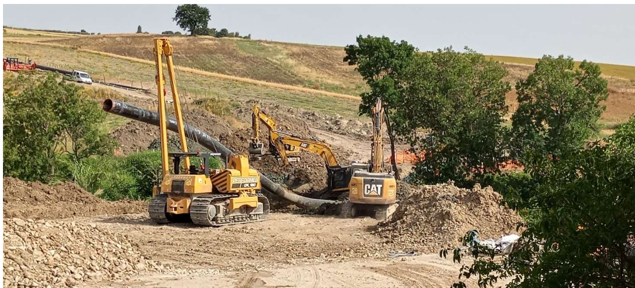
Figura 3.3 – SUP02MN – Fase di scavo e posa della condotta
