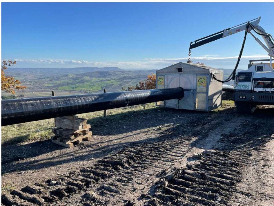
Figura 2.6 – Fase di saldatura della linea
