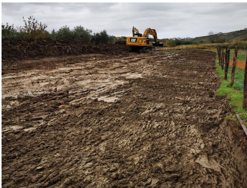
Fig. 1 – Apertura pista di lavoro con accantonamento (a sinistra) dello strato superficiale di terreno (humus)
