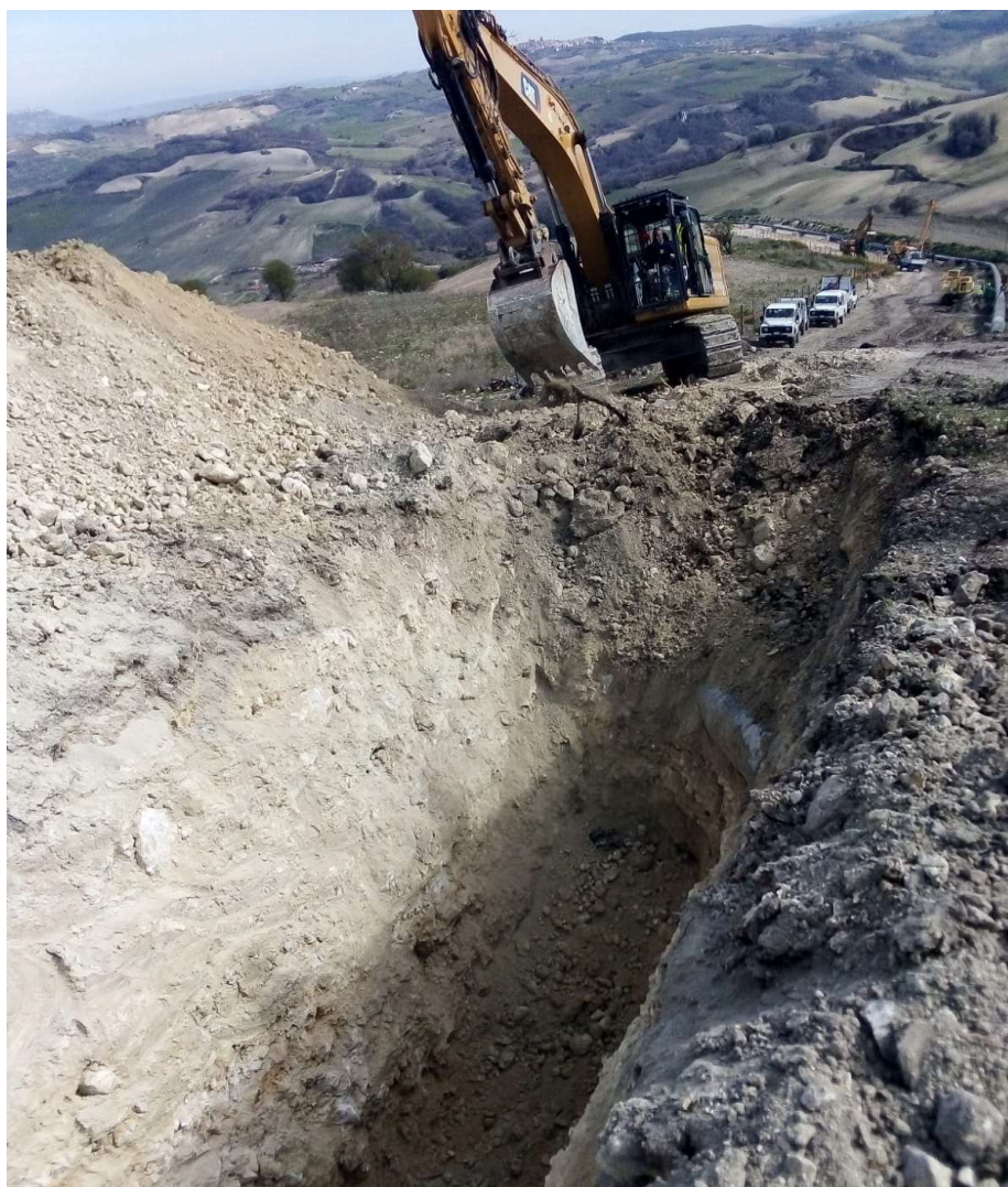
Figura 2.3 – SUP01MN - Scavo della trincea
