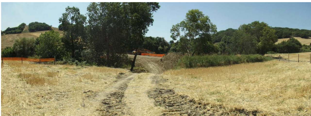
Figura 3.3 – preparazione dei lavori per l'apertura del cantiere presso il punto SUP02MN.
