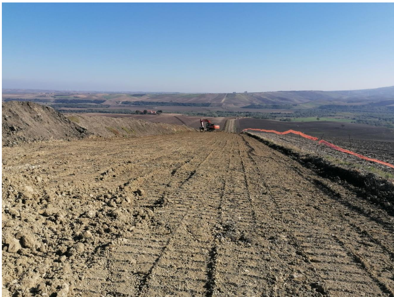
Fig. 4 – Preparazione dello strato di contatto terreno-humus (riprofilatura)
