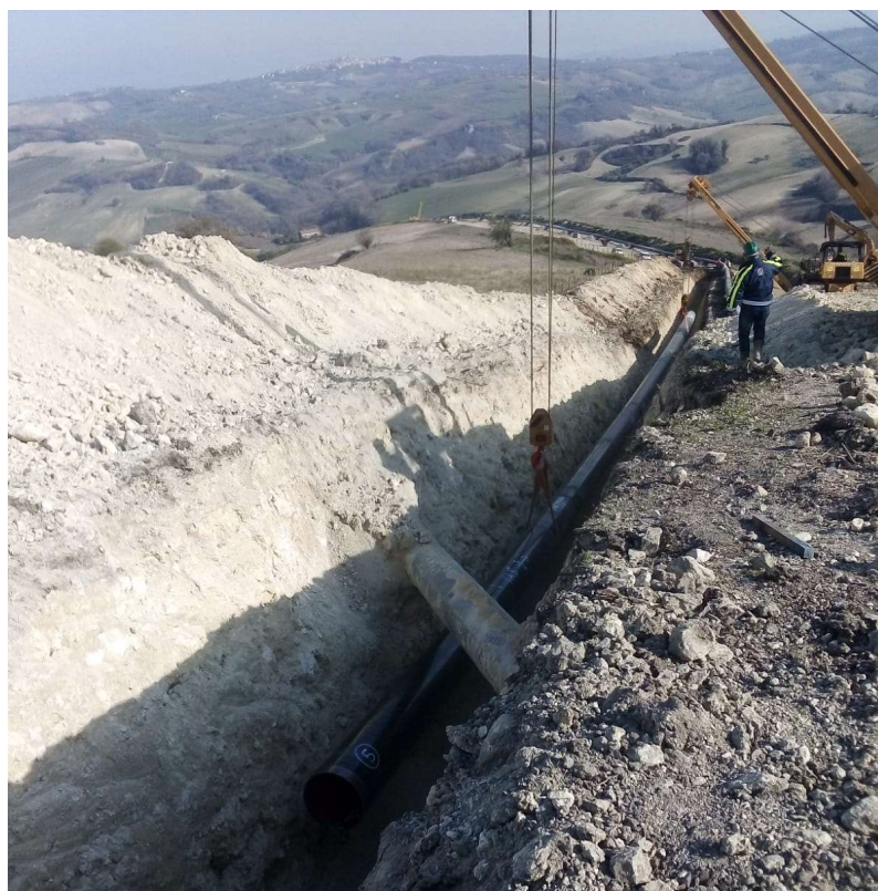
Figura 2.5 – SUP01MN - Fase di posa della condotta
