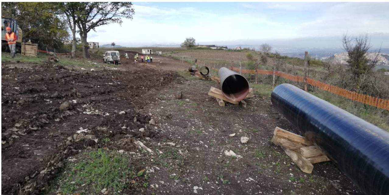
Figura 2.4 – Sfilamento delle tubazioni lungo l’area di passaggio.
