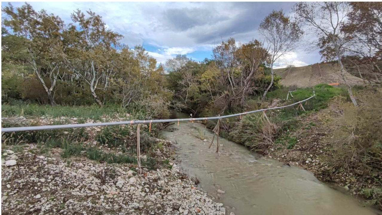
Figura 4.5 – Cantiere aperto presso il torrente Cigno (destra idrografica) e nel tratto collinare in risalita subito oltre.
