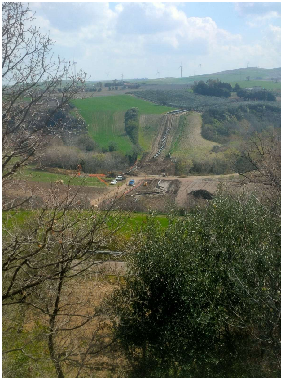
Figura 4.3 – SUP04UR – Vista del cantiere durante le attività propedeutiche allo scavo
