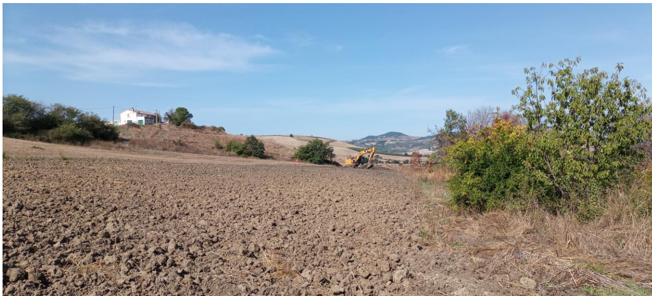
Fig. 5 – Ripristino definitivo dello strato di terreno superficiale (humus)
