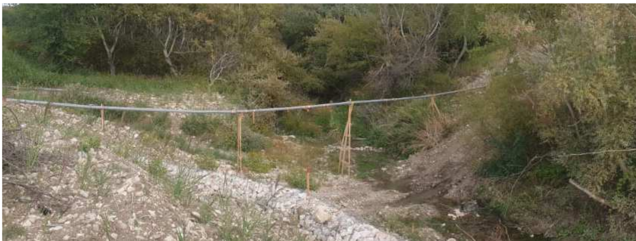
Figura 4.3 – preparazione dei lavori per l’apertura del cantiere presso il punto SUP04UR – Torrente Cigno
