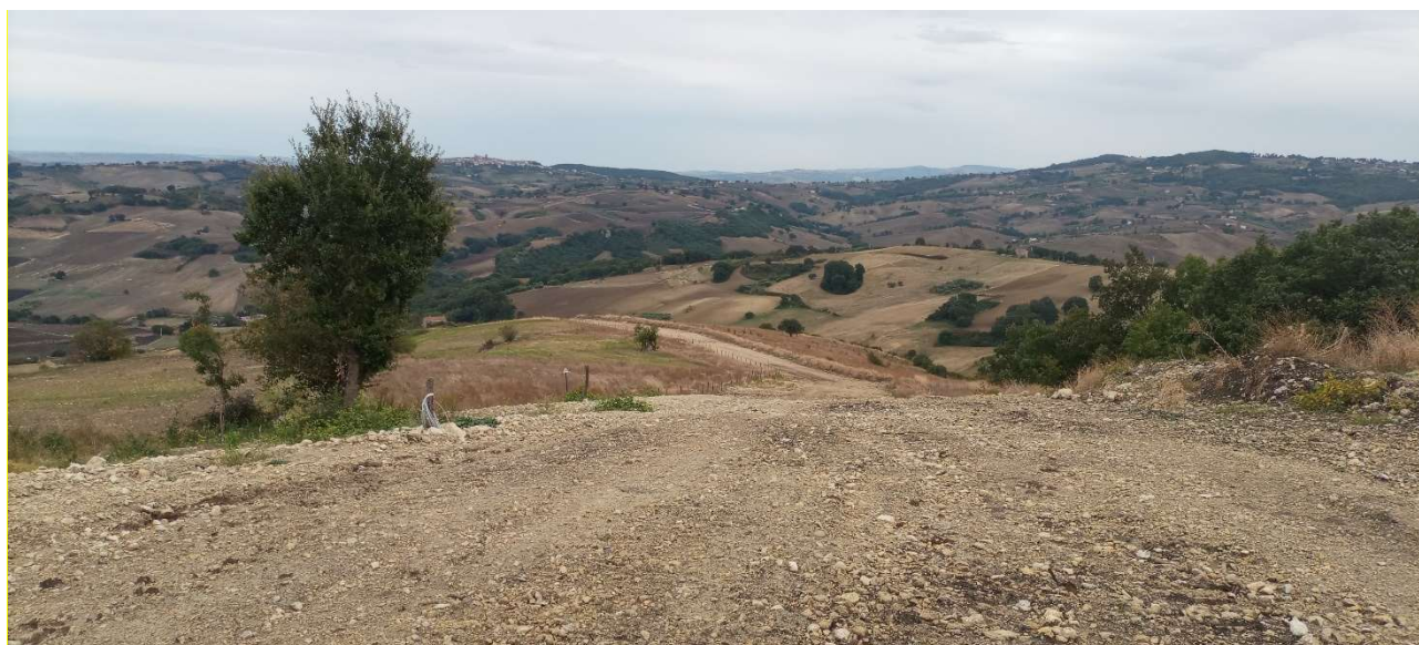
Figura 2.7 – SUP01MN – Vista dell’area al termine della fase di rinterro.
