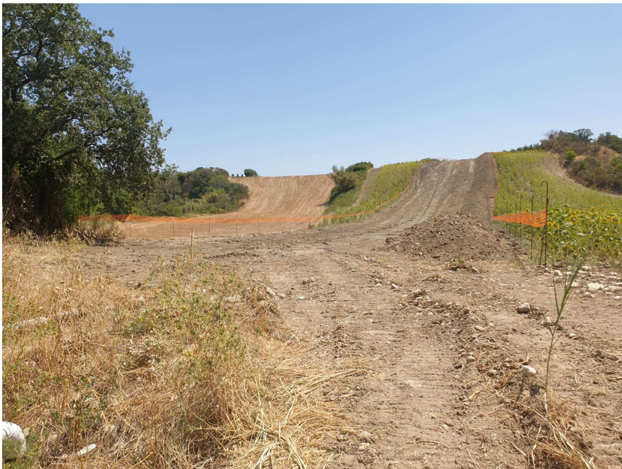
Figura 4.4 – Delimitazione della pista di lavoro e scotico dell’humus nel tratto relativo al punto di monitoraggio SUP04UR in destra idrografica del torrente Cigno.
