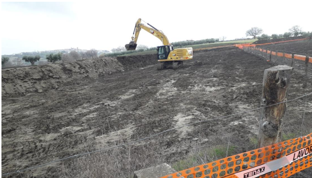
Fig. 2 – Completamento della fase di apertura pista di lavoro con accantonamento (a sinistra) dello strato superficiale di terreno (humus)
