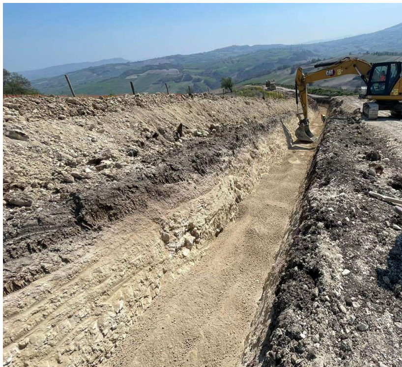
Figura 2.6 – SUP01MN – Esecuzione della fase di rinterro
