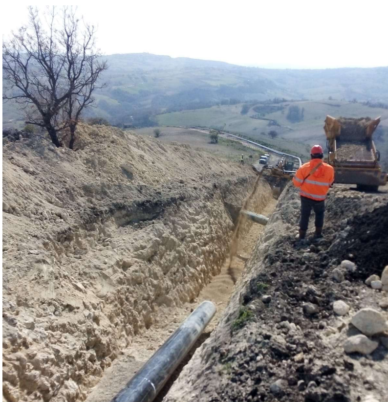
Figura 2.4 – SUP01MN - Realizzazione del letto di posa
