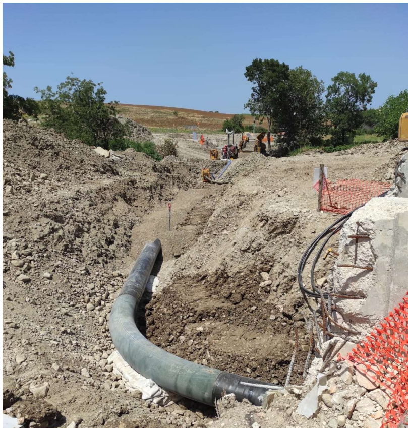
Figura 3.4 – SUP02MN – Fase di pre-rinterro
