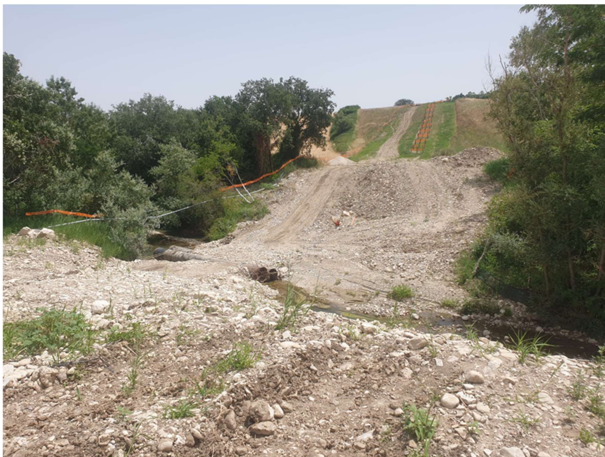
Figura 4.5 – SUP04UR – Vista dell’area al termine delle attività di rinterro
