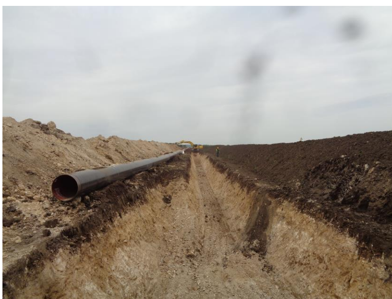
Fig. 2 – Scavo della trincea – separazione tra terreno scavato (a sinistra) e l'humus precedentemente accantonato (a destra)
