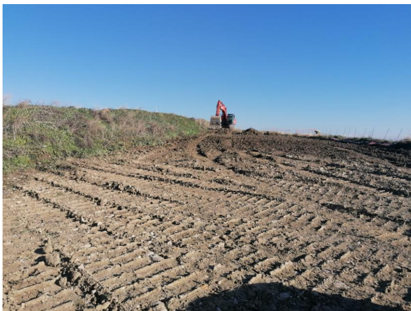
Fig. 3 – Preparazione dello strato di contatto terreno-humus (riprofilatura)
