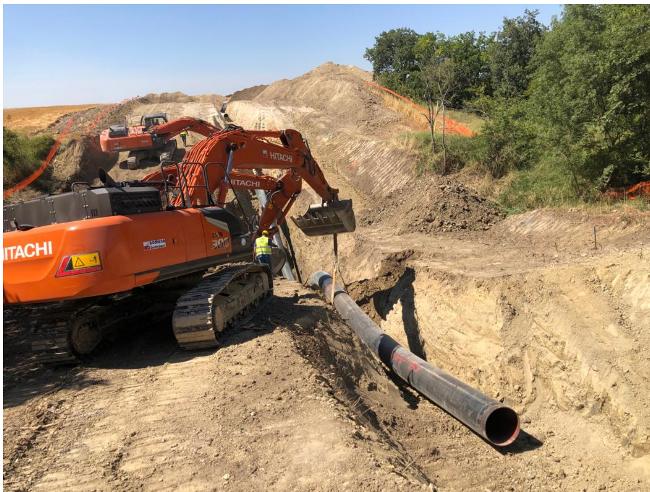
Figura 2.8 - Punto di monitoraggio SUP05CS – Posa della tubazione
