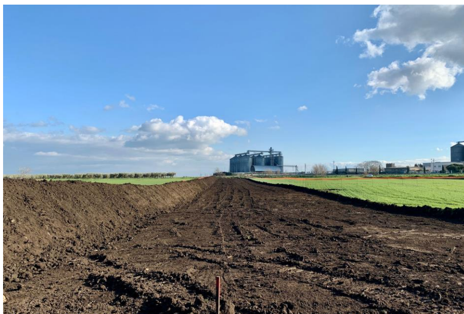
Fig. 1 – Apertura pista di lavoro con accantonamento (a sinistra) dello strato superficiale di terreno (humus)
