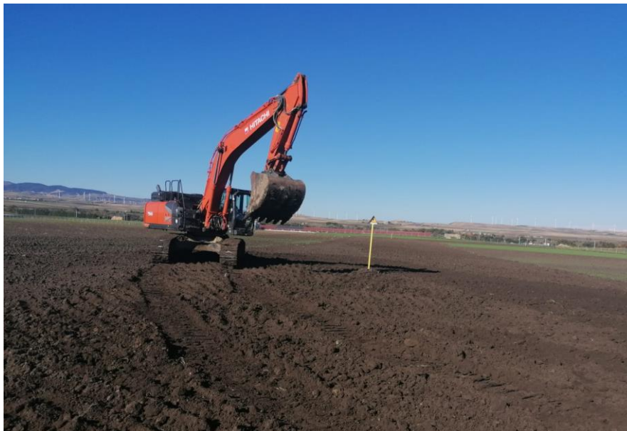
Fig. 4 – Ripristino definitivo dello strato di terreno superficiale (humus)
