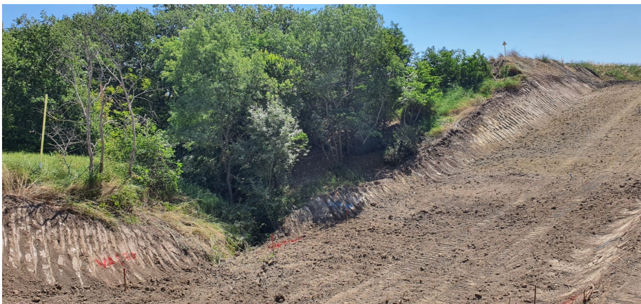
Figura 2.6 - Punto di monitoraggio SUP05CS - Apertura area di passaggio
