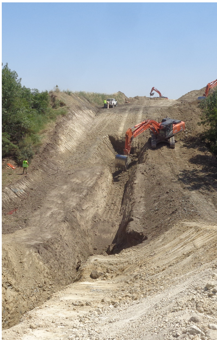
Figura 2.7 - Punto di monitoraggio SUP05CS – Scavo della trincea
