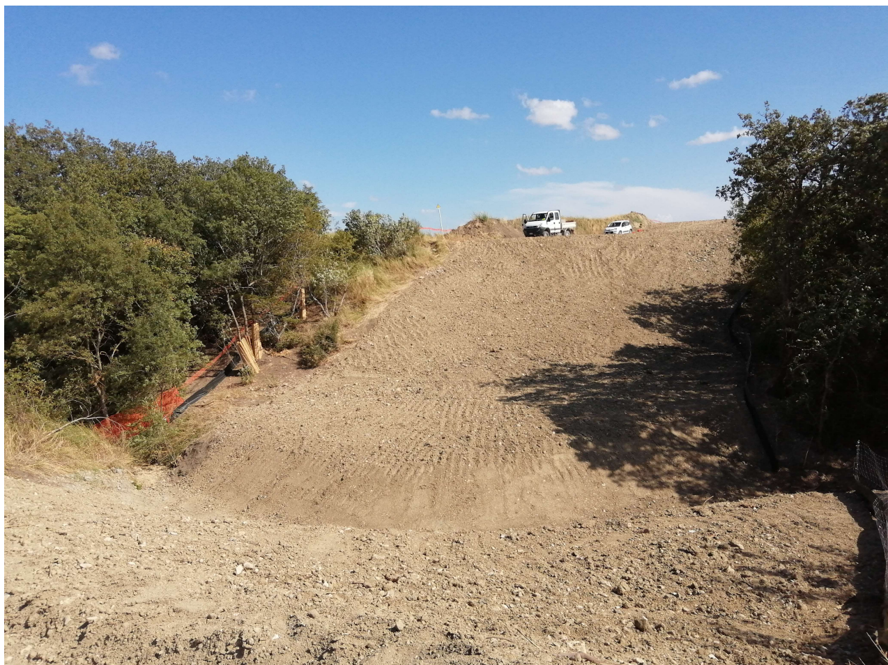
Figura 2.9 - Punto di monitoraggio SUP05CS – Vista dell’area dopo l’esecuzione del rinterro e della riprofilatura
