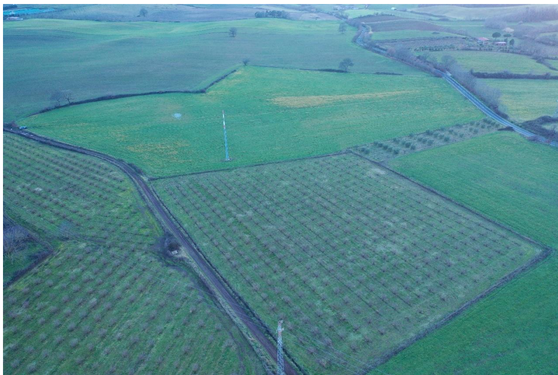
Figura 25 – IMMAGINE DALL’ALTO DEL SITO PER LA COSTRUZIONE DELLA SE VALENTANO
