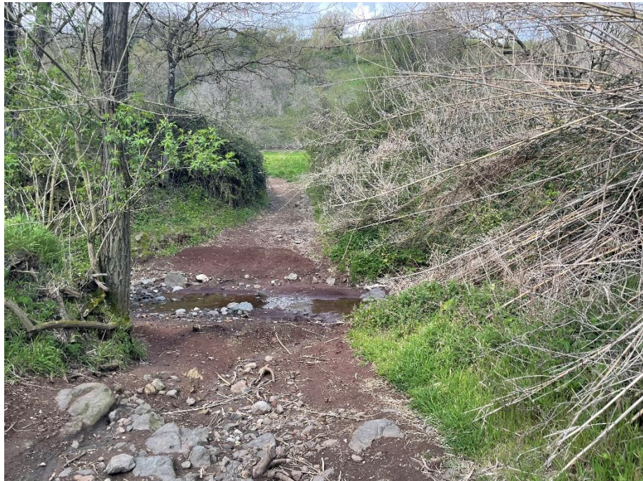
Figura 31 – ATTRAVERSAMENTO DELL'ELETTRODOTTO INTERRATO DEL FOSSO 5 MEDIANTE TOC
