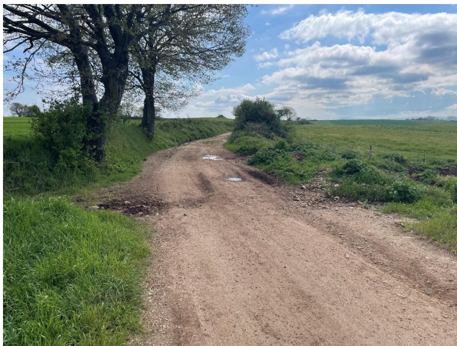
Figura 29 – ATTRAVERSAMENTO DELL'ELETTRODOTTO INTERRATO DEL FOSSO 2 MEDIANTE TOC
