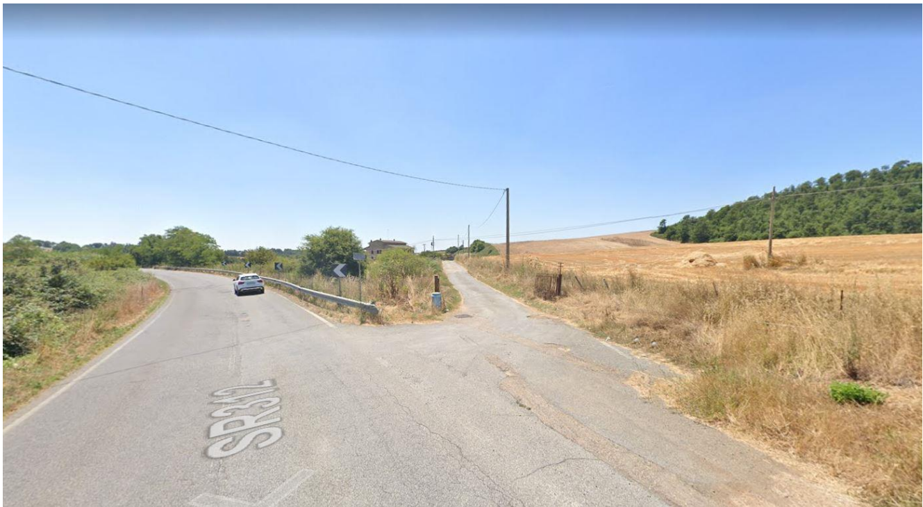
Figura 8 - BIVIO PER STRADA COMUNALE DI ACCESSO AL LOTTO A
