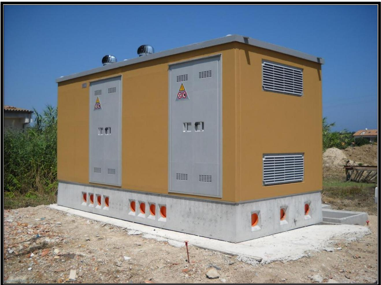
**Figura 13 - ESEMPIO DI CABINA DI PARALLELO MT**
