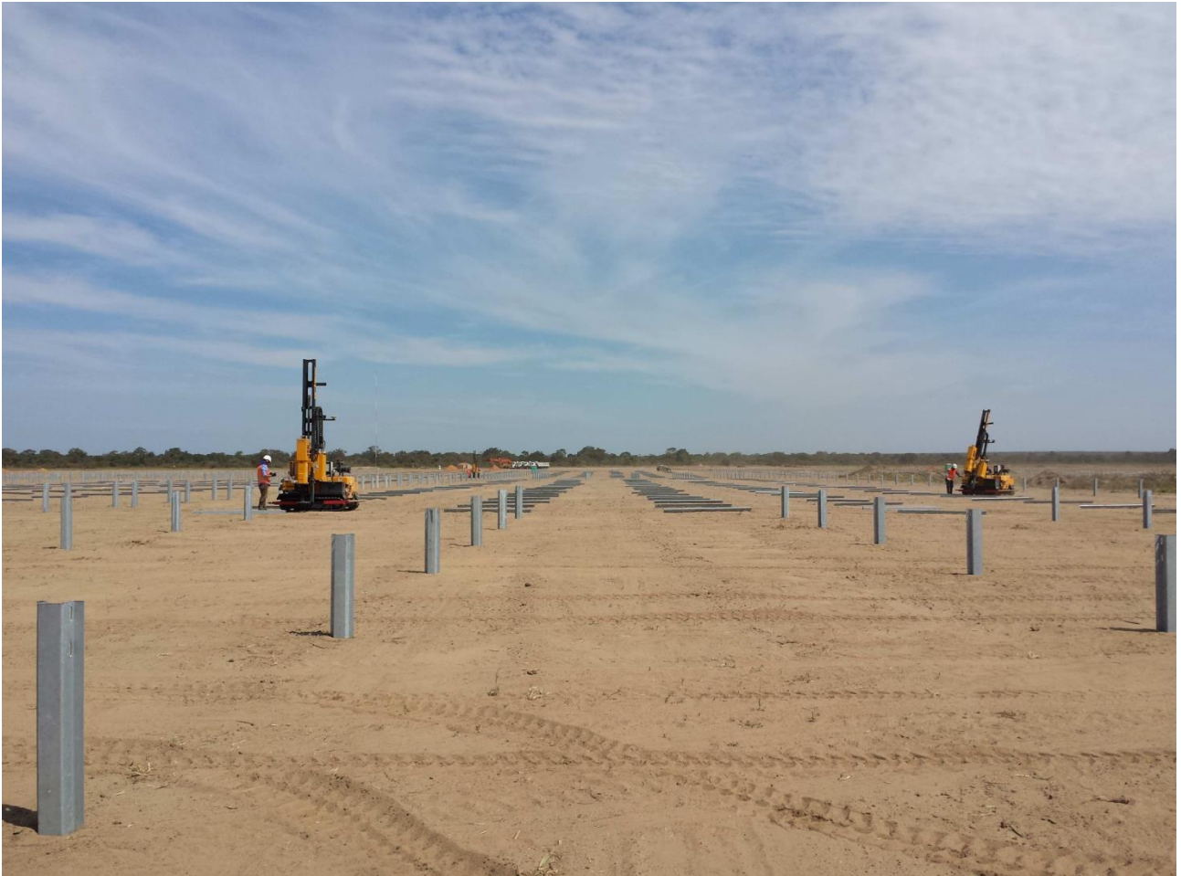
Figura 5.2 – Fase di infissione dei pali con profilo omega (fonte Convert)
