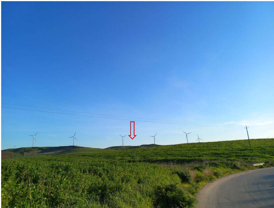
Figura 30: Vista dal punto 6 sulla SP50_ In rosso indicata la direzione dell'area di progetto
