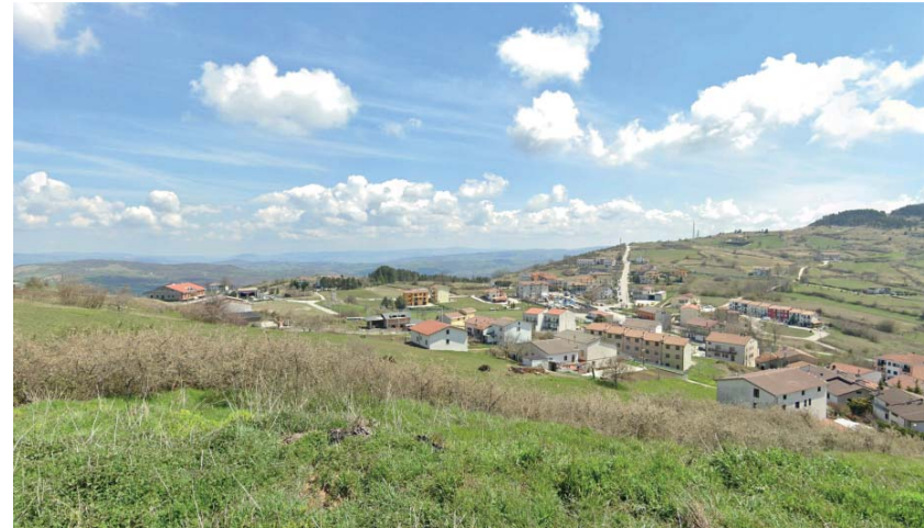
(F7) CERCEMAGGIORE_Chiesa di Santa Maria del Monte: Stato di fatto
